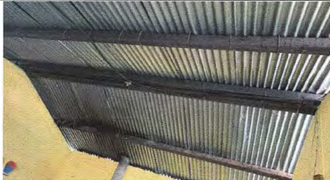
FOTO 2 MODULO 1: Sustrución de estructura de soporte de metal por metal
