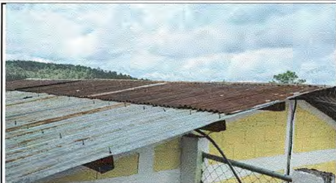
FOTO 1 MODULO 1: Sustrución de lámina, por lámina troquelada
