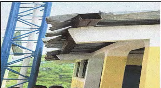
FOTO 3 Modulo 1: Sustrución de canal y bajada de agua
