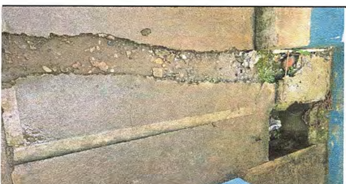
FOTO 6 Modulo 3: Reparación de plancha de concreto de patio.
