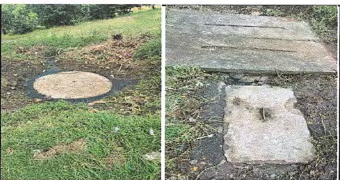
FOTO 5 Modulo 2: Sustrución de biodigestor
