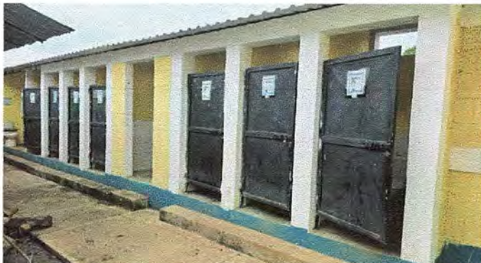
FOTO 4 Modulo 2: mantenimiento a estructura de puertas de sanitarios
