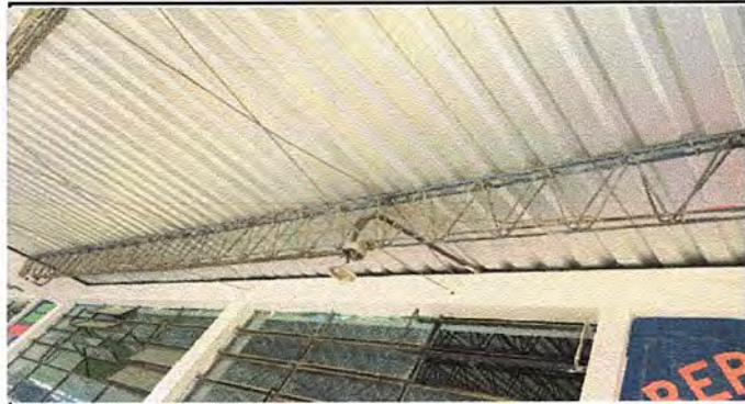
FOTO 7 MODULO 4: Reparacion de cableado electrico
