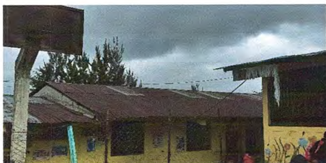
Foto 3: MODULO 3: Desinstalacion de lámina existente
