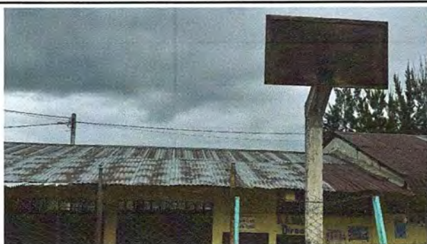
Foto 5: MODULO 3: Sustitución de lámina por lámina troquelada aluzinc calibre 26
