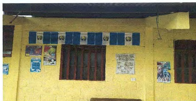
Foto 11: MODULO 3: Suministro e insatacion de balcones de metal
