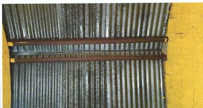
Foto 8: MODULO 3: Reparación de estructura de soporte de metal.
