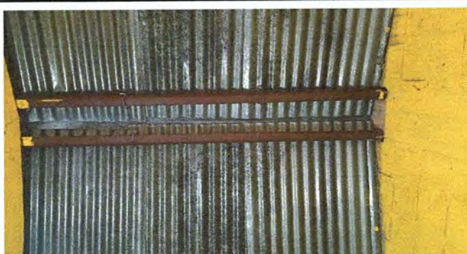
Foto 10: MODULO 3: Instalación de estructura portante de metal
