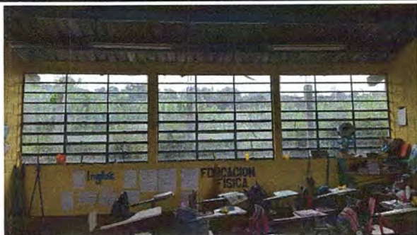
Foto 1: MODULO 2: Suministro e insalacion de balcones de metal
