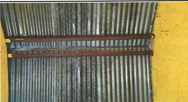
Foto 9: MODULO 3: Desinstalacion de estructura portante de metal
