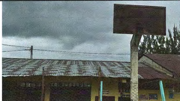
Foto 6: MODULO 3: Sustitucion de capote de lámina para lámina troquelada
