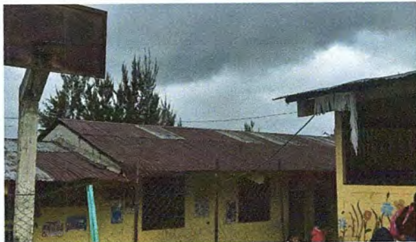
Foto 7: MODULO 3: Sustitucion de elementos de fijacion (tornillos)
