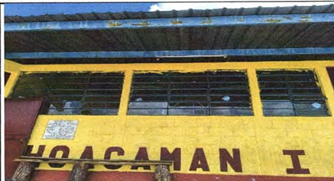
Foto 2: MODULO 2: Suministro e insalacion de balcones de metal
