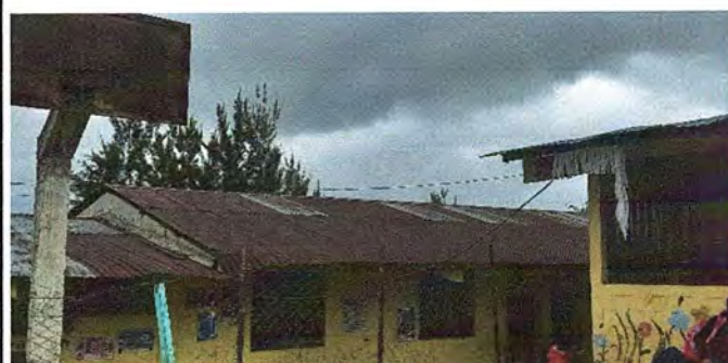
Foto 4: MODULO 3: Instalación de lámina troquelada aluzinc
