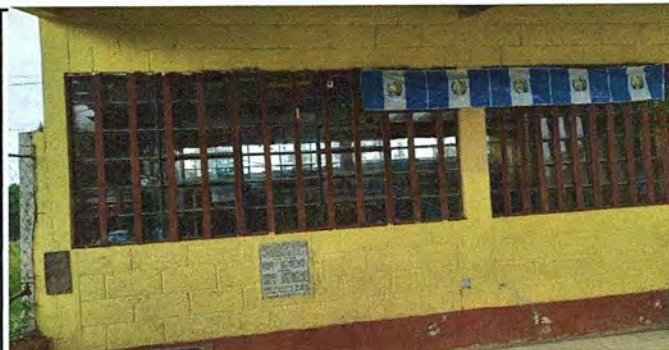
Foto 12: MODULO 3: Suministro e insatacion de balcones de metal
