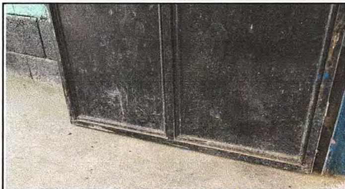
Foto1: Modulo 1, Mantenimineto a estructura de puerta (lijado, cepillado, sujeciones, aplicacion de pintura)
