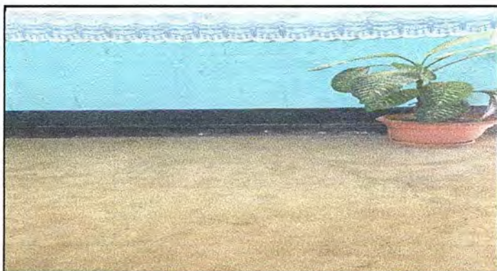
Foto 3: Modulo 1, Sustitución de piso de torta de concreto
