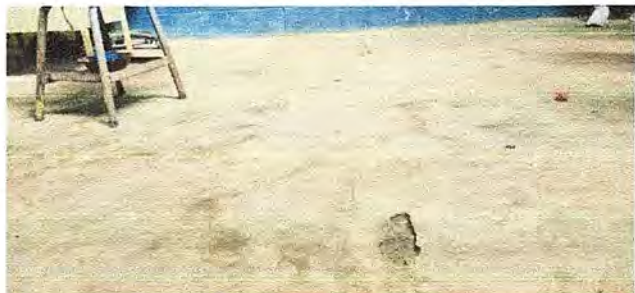
Foto 1: MÓDULO 2 Sustrucción de torta de concreto por piso cerámico
