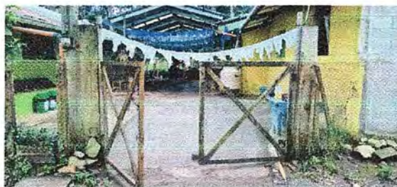
Foto 4: MÓDULO 3 Sustrucción de portón de ingreso por metal (4.00x3.55)
