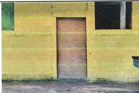
Foto1: MÓDULO 1 Sustitución de puerta de madera por metal
