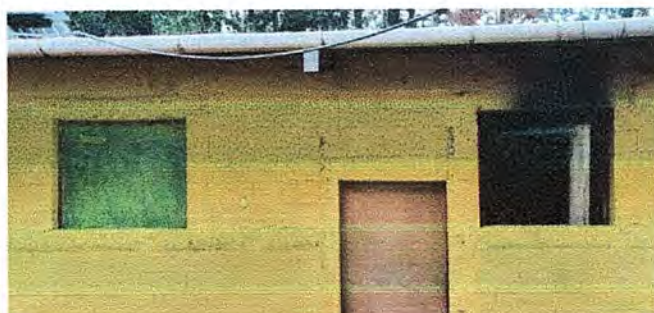
Foto 2: MÓDULO 1 Sustitución de ventana de madera por metal
