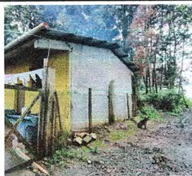
Foto 4: MÓDULO 1 Pintura en muros exteriores e interiores
