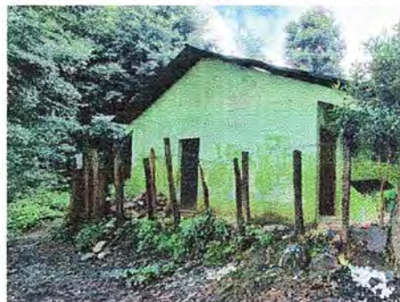
Foto 2: MÓDULO 2 Pintura en muros exteriores e interiores
