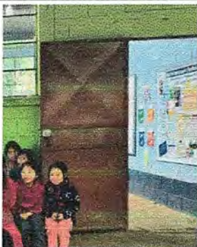
Foto 3: MÓDULO 2 Mantenimiento a estructura de puerta (lijado, aplicación de pintura)
