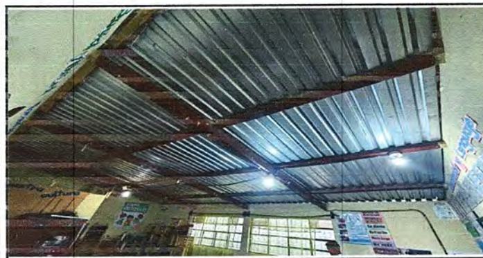
Foto 5: MÓDULO II: Desinstalación de lámina existente, desinstalación de estructura portante, sustitución de estructura de soporte de madera, por metal, instalación de estructura portante metal, sustitución de canal de pvc, instalación de lámina existente.
