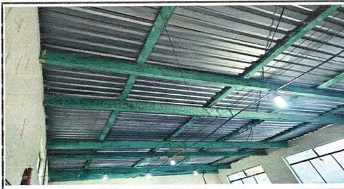
Foto 2: MÓDULO I: Desinstalación de lámina existente, desinstalación de estructura portante, sustitución de estructura de soporte de madera, por metal, instalación de estructura portante metal, sustitución de canal de pvc, instalación de lámina existente.
