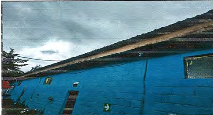
Foto 4: MÓDULO II: Desinstalación de lámina existente, desinstalación de estructura portante, sustitución de estructura de soporte de madera, por metal, instalación de estructura portante metal, sustitución de canal de pvc, instalación de lámina existente.
