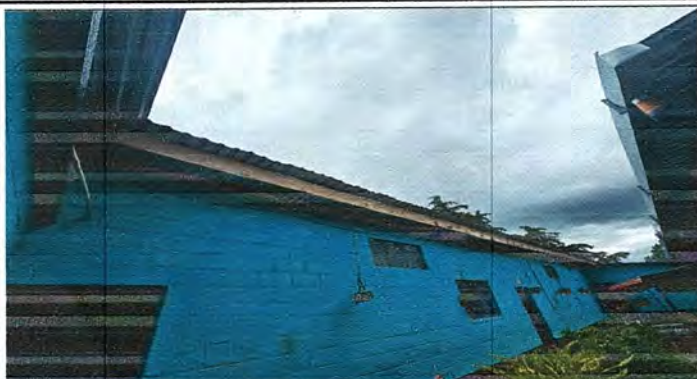
Foto1: MÓDULO I: Desinstalación de lámina existente, desinstalación de estructura portante, sustitución de estructura de soporte de madera, por metal, instalación de estructura portante metal, sustitución de canal de pvc, instalación de lámina existente.
