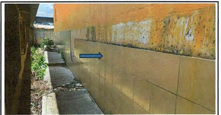
Modulo 1, foto 4: Sustitución azulejo en pared
