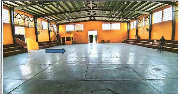
Modulo 1, foto 2: Sustitución de piso ceramico
