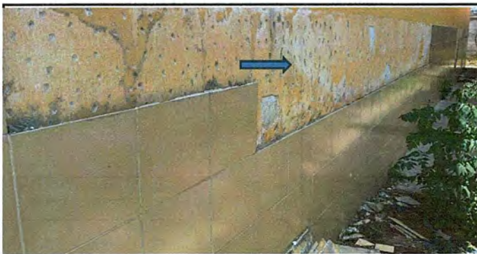
Modulo 1, foto 3: Sustitución de azulejo en pared
