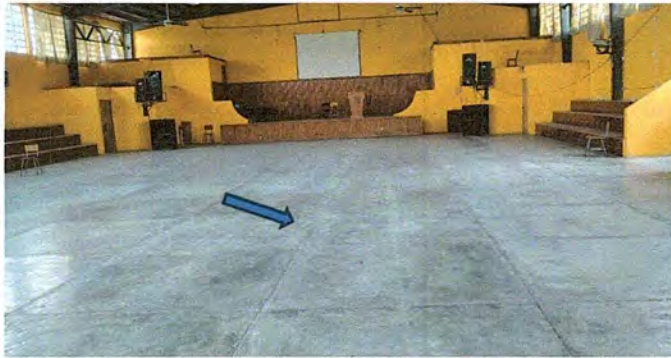
Modulo 1, foto 1: Sustitución de piso ceramico
