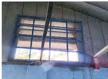
Foto 5: MÓDULO 3. VENTANAS. Sustitución de estructura de metal de ventana.
