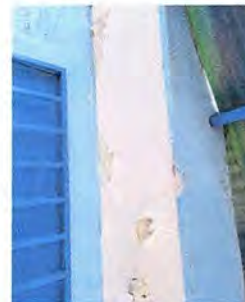
Foto 4: MÓDULO 3. PINTURA EN MUROS EXTERIORES E INTERIORES: Pintura en muros exteriores e interiores.
