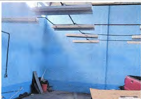
Foto 3: MÓDULO 3. Reparación de sistema eléctrico, sustitución de lámparas tipo LED.
