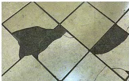
Foto1: BAÑO: Sustitución de piso ceramico
