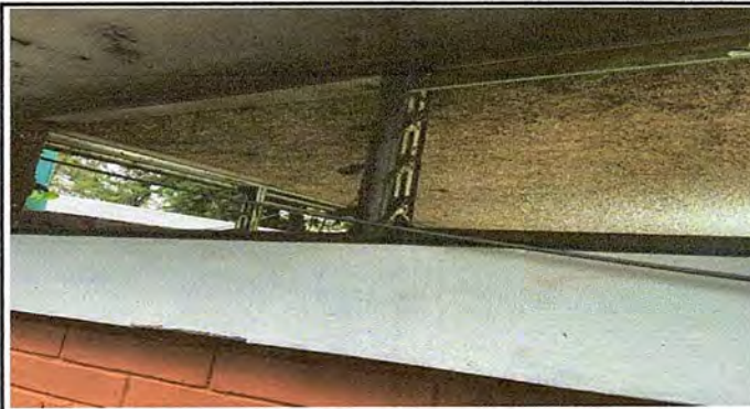
Foto 8: BAÑO. Sustitución de ventana de aluminio por PVC.
