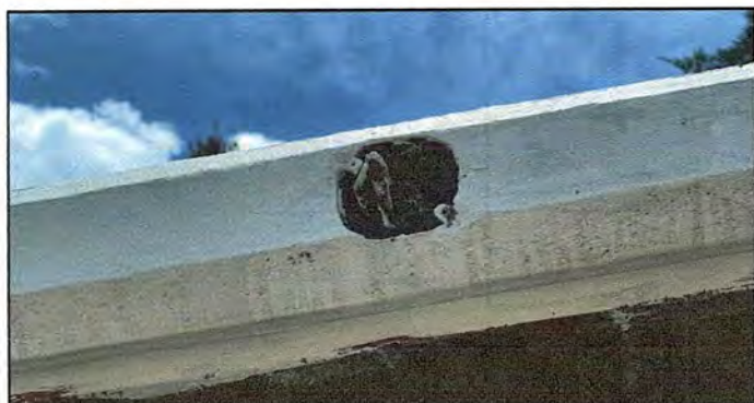
Foto 9: MÓDULO 1. Sustitución de lámparas LED (reflectores)
