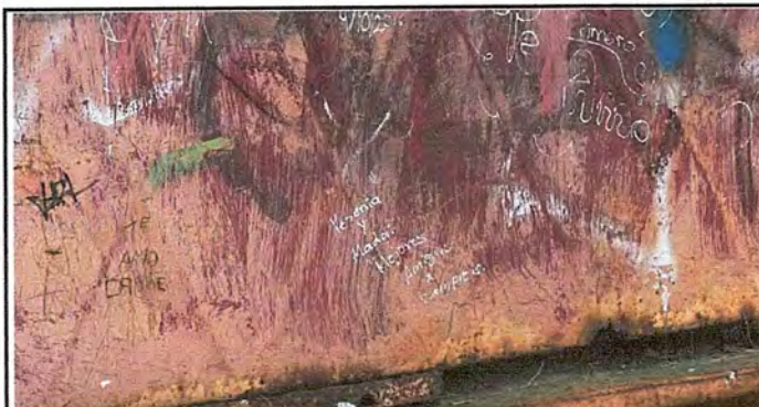
Foto 11. ÁREA EXTERIOR. Reparación de bodega de metal
