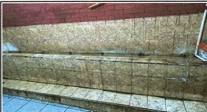
Foto 7: BAÑO. Sustitución de azulejo.
