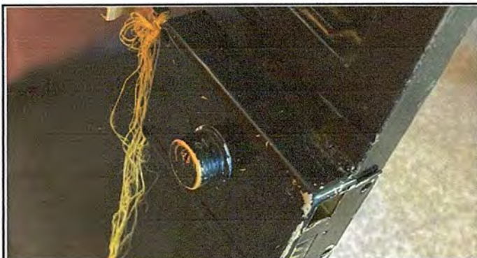
Foto 10. MÓDULO 1. Mantenimiento a estructura de puerta (cambio de chapa)
