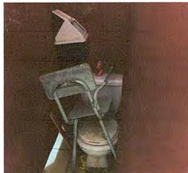
Foto 2: BAÑO: Sustitución de inodoro
