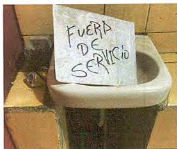
Foto 5: BAÑO: Sustitución de lavamanos
