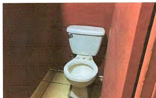
Foto 3: BAÑO: Sustitución de puerta de metal
