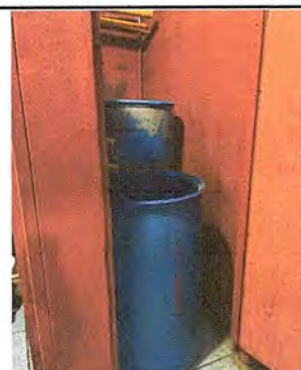
Foto 4: BAÑO: Sustitución de inodoro de baño de hombres
