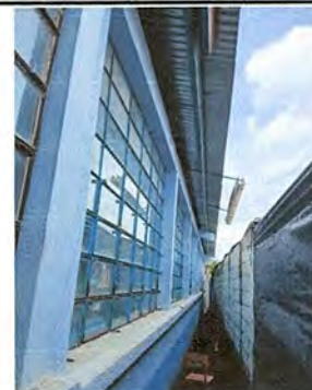
Foto 6: Sustitución de canal, soporte, bajada de agua, parte posterior módulo II salón y módulo III aulas
