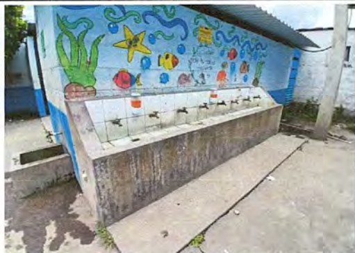
Foto 3: Sustitución de azulejo de lavamanos y llave de chorros, módulo I: Baños y lavamanos
