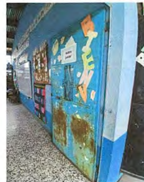
Foto 4: Desinstalación, fabricación e instalación de puertas de metal, módulo II: Salón
