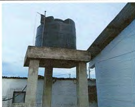
Foto 5: Sustitución de depósito de agua 1700 lts. Módulo exterior.
