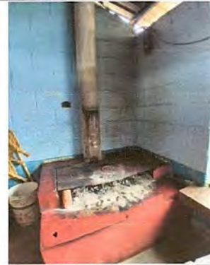
Foto 8: Sustitución de estufa rural, chimenea y plancha de metal, módulo V: Cocina
