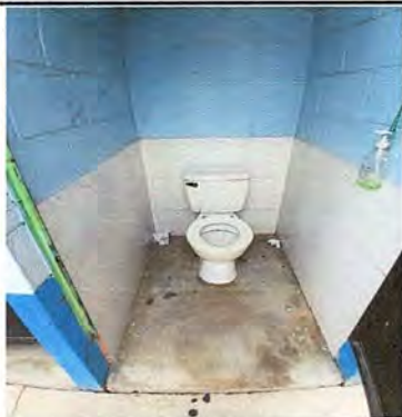
Foto 1: Sustitución de azulejos e inodoros, módulo I: Baños y lavamanos
