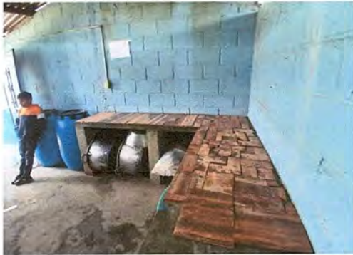
Foto 7: Sustitución de azulejos, módulo V: Cocina
