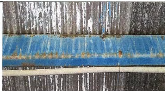
Foto 6: MODULO 1. Mantenimiento a estructura de soporte de metal
