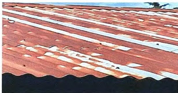
Foto 3: MODULO 1. Sustrucción de elementos de fijación (tornillos)
