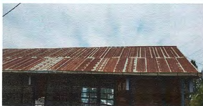
Foto 5: MODULO 1. Instalación de lámina troquelada aluzinc
