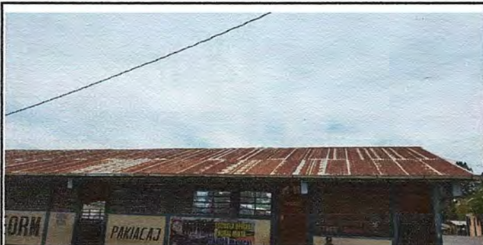
Foto1: MODULO 1. Sustrucción de lámina, por lámina troquelada aluzinc calibre 26
