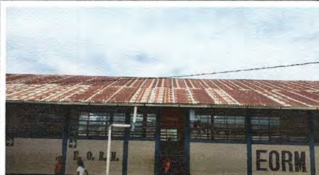
Foto 4: MODULO 1. Desinstalación de lámina existente
