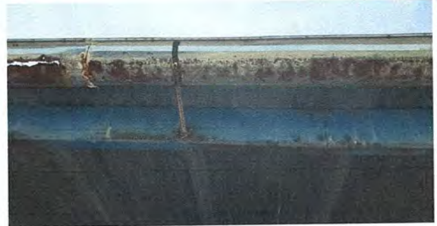
Foto 10: MODULO 1. Sustrucción de canal de metal
