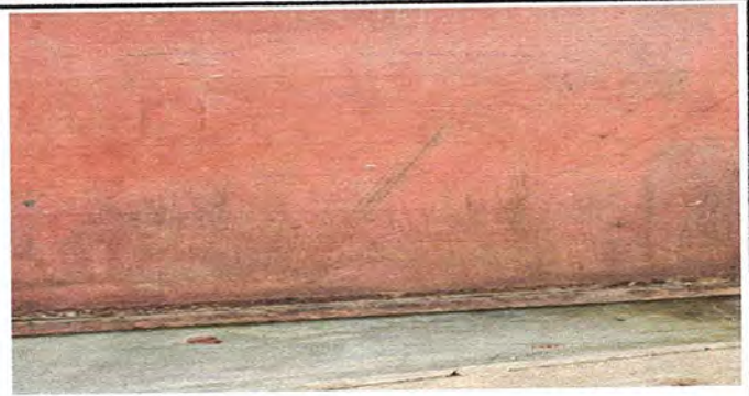
Foto 8: MODULO 1. Mantenimiento a estructura de puerta (lijado, cambio de tubo, cepillado, sujeciones, aplicación de pintura)
