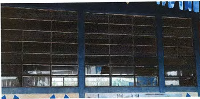
Foto 9: MODULO 1. Fabricación e instalación de balcón de hierro en ventana
