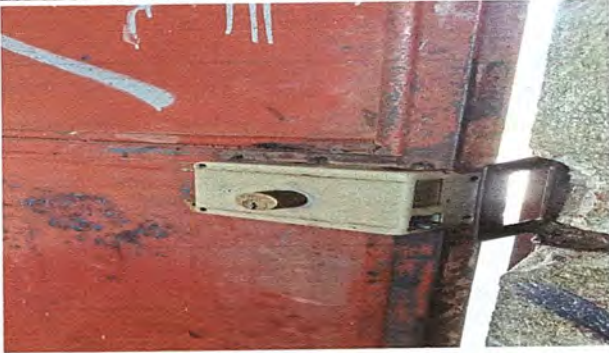
Foto 7: MODULO 1. Sustrucción de chapa
