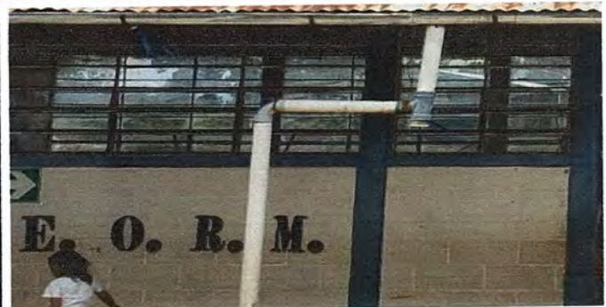
Foto 12: MODULO 1. Sustrucción de bajada de agua pluvial de metal por tubo PVC 3"
