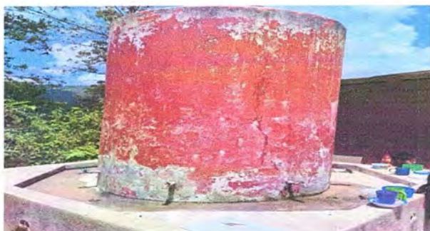
Foto 3: Modulo 3: Reparación de cisterna de concreto alizado
