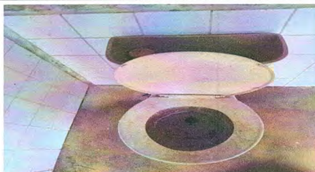
Foto 3: Módulo 2; Sustitucion de inodoro
