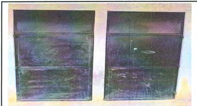
Foto1: Módulo 1 : Fabricación e instalación de puerta de metal
