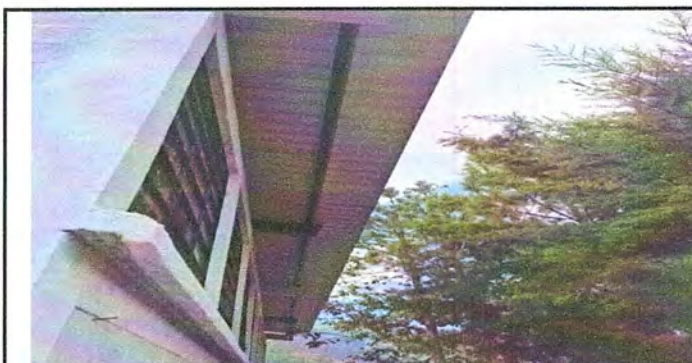
Foto 3: Módulo 1: Sustitución de canal de metal
