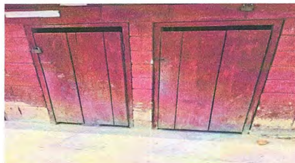
Foto 2: Módulo 2 :Fabricación e instalacion de puertas de metal de baño
