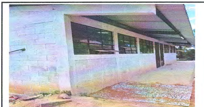
Foto 4: Módulo 1 : Pintura en muros exterior e interior
