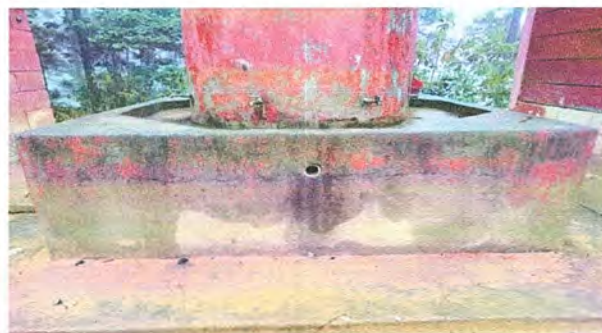
Foto 2: Modulo 3: Reparación de piso de cemento liquido
