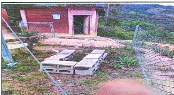
Foto 4: Modulo 4: Sustición de deposito de agua 100lt
