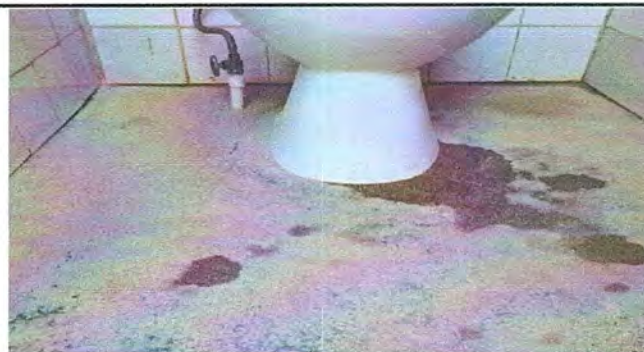
Foto 6: Módulo 3: Reparación de piso de cemento liquido (baño)
