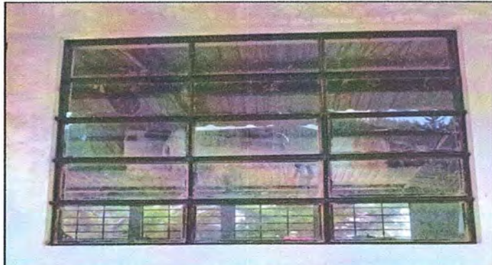
Foto 2: Módulo 1: Fabricacion e instalación de balcones en ventanas
