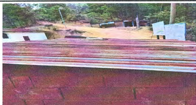
Foto 5: Módulo 2: Sustitución de lámina por lamina troquelada aluzinc calibre 26
