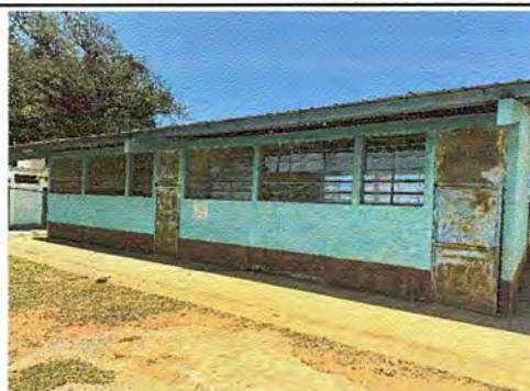
Foto 5: Módulo 1: Pintura en paredes en interiores y exteriores.
