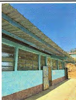
Foto 3: Módulo 1: Sustitución de canales y bajadas pluviales.
