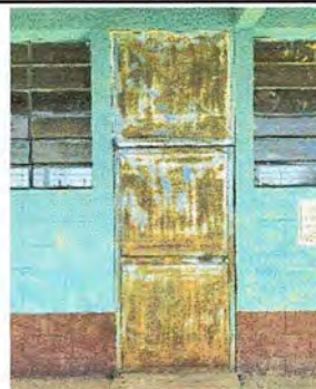
Foto 4: Módulo 1: Mantenimiento de estructura de puerta (lijado, cepillado, aplicación de pintura y cambio de chapa)
