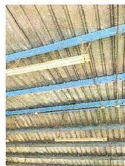
Foto 6: Módulo 1: Sustitución de lámparas tipo led.
