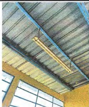
Foto 1: Módulo 1: Sustitución de lámina y mantenimiento a estructura de soporte
