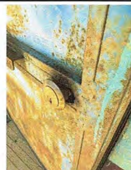
Foto 4: Módulo 1: Mantenimiento de estructura de puerta (lijado, cepillado, aplicación de pintura y cambio de chapa)
