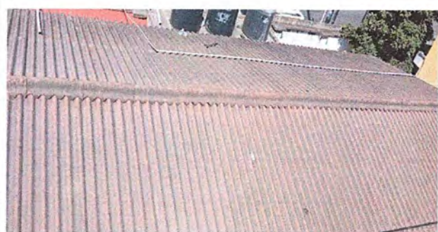
Foto 3: MÓDULO 3: Sustitución de lámina por lámina troquelada aluzinc.
