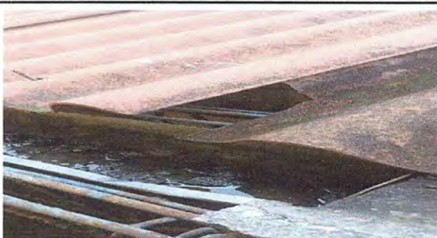
Foto 9: MÓDULO 3: Sustitución de canal de metal.
