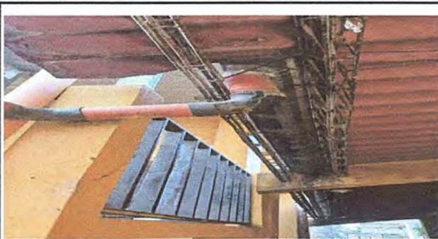
Foto 10: MÓDULO 3: Sustitución de soporte o pescante de metal para canal.
