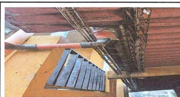
Foto 6: MÓDULO 3: Mantenimiento a estructura de soporte de metal.
