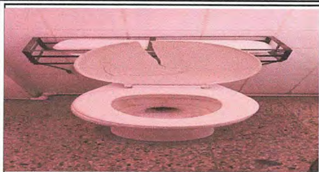
Foto 1: MÓDULO 1: Sustitución de inodoros.
