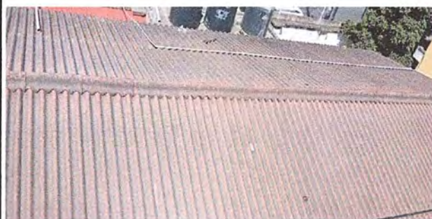
Foto 8: MÓDULO 3: Instalación de lámina troquelada aluzinc.
