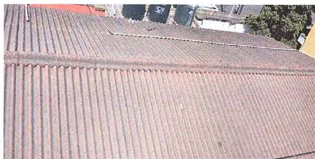
Foto 7: MÓDULO 3: Desinstalación de lámina existente.
