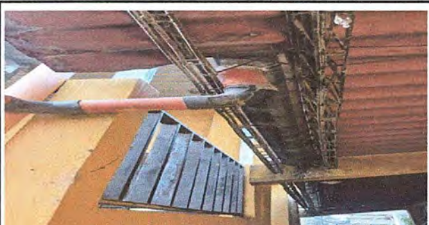
Foto 11: MÓDULO 3: Sustitución de bajada de agua pluvial pvc de 3".
