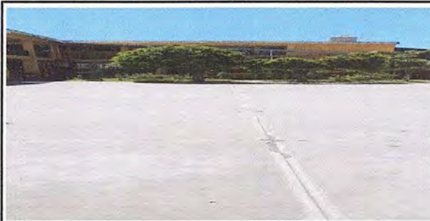
Foto 16: ÁREAS EXTERIORES: Reparación de torta de concreto.
