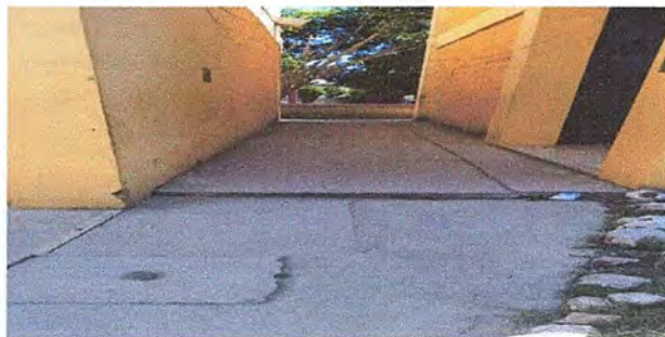
Foto 14: ÁREAS EXTERIORES: Mantenimiento a cajas de registro.
