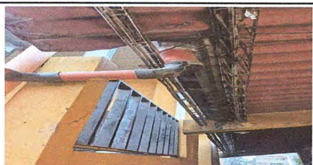
Foto 5: MÓDULO 3: Sustitución de elementos de fijación.
