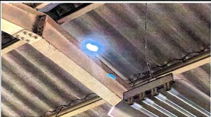
Foto 3: MÓDULO 1. Cubierta del Lámina
