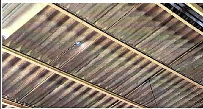
Foto 1: MÓDULO 1 Estructura de techo.
