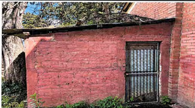
Foto13: MÓDULO 2. Puertas de metal.
