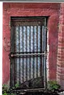
Foto 14: MÓDULO 2. Puertas de metal.
