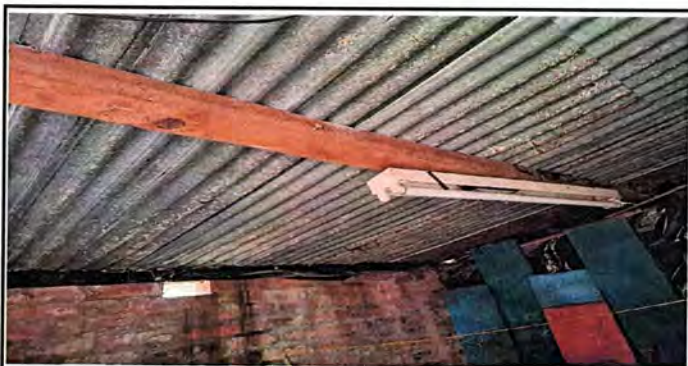
Foto17: MÓDULO 2. Estructura de techo.
