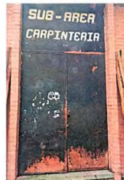
Foto 8: MÓDULO 1. Puertas de metal.
