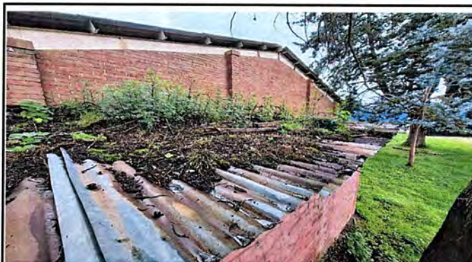
Foto 16: MÓDULO 2. Cubierta del Lámina
