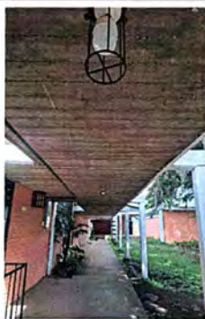
Foto 11: Suministros Eléctricos Corredores
