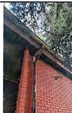
Foto 6: MÓDULO 1. Canales y Bajas de Agua Pluvial
