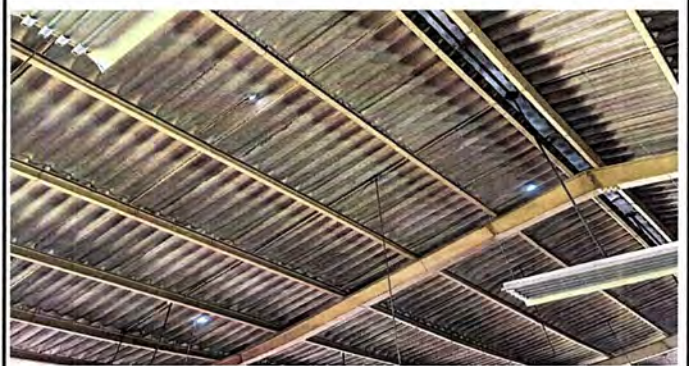
Foto 2: MÓDULO 1. Estructura de techo.
