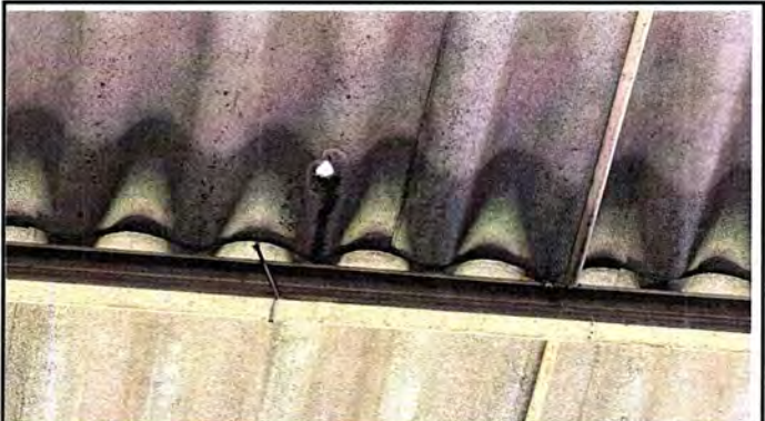
Foto 4: MÓDULO 1. Cubierta del Lámina
