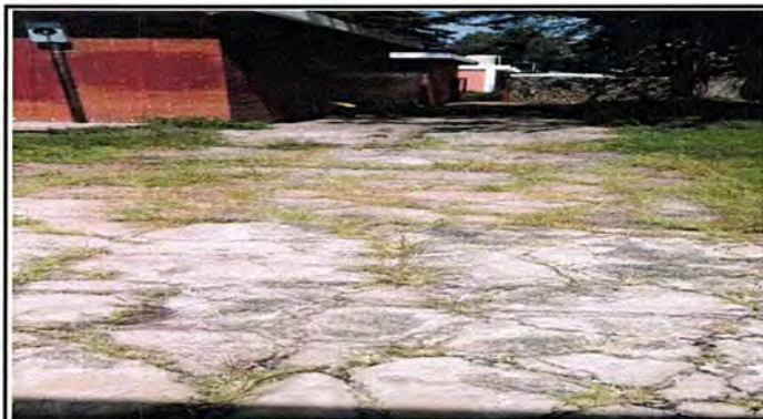
Foto 9: Losa de Patio.
