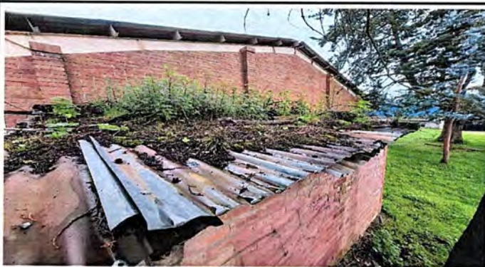
Foto15: MÓDULO 2. Cubierta del Lámina
