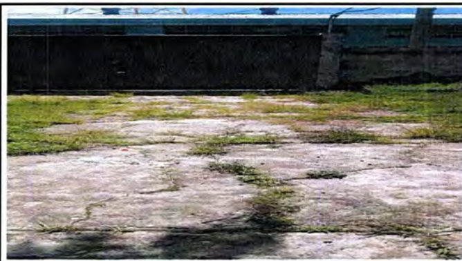
Foto 10: Losa de Patio.
