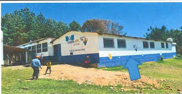
Foto 11. Pintura en muros exteriores e interiores.
