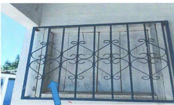
Foto. 4 MODULO 1: Sustrucción de balcon de metal 1.00x1.20
