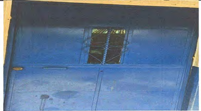
Foto. 8 MODULO 2: - Mantenimiento a estructura de puerta )lijado, cambio de tuvo, cepillado, sujeciones, aplicación de pintura)
