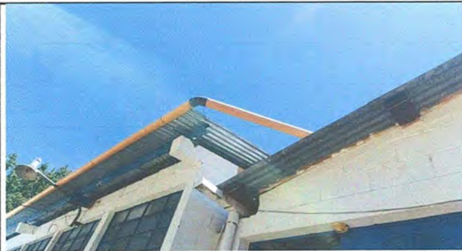
Foto. 9 MODULO 2 Sustitución de canal de metal
