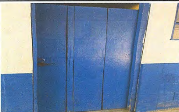
Foto.3 MODULO 1: - Sustrucción de puerta de madera a metal
