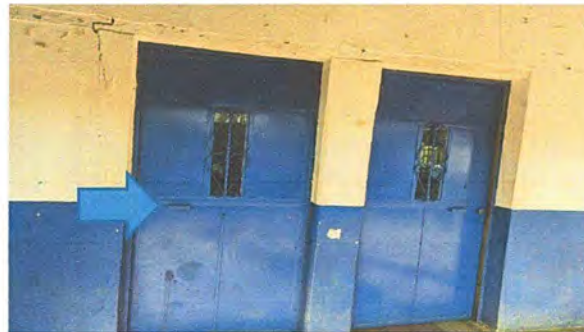
Foto. 2 MODULO 1: - Mantenimiento a estructura de puerta (lijado, cambio de tuvo, cepillado, sujeciones, aplicación de pintura).
