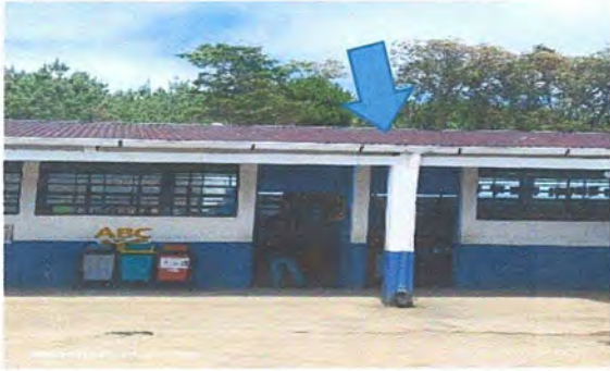
Foto. 7 MODULO 2: -Sustitución de láminas, por láminas troqueladas alñuzinc calibre 26
