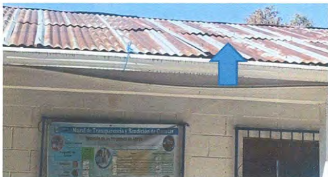
Foto. 1 MODULO 1: Sustrucción de lámina, por lámina troquelada aluzinc calibre 26
