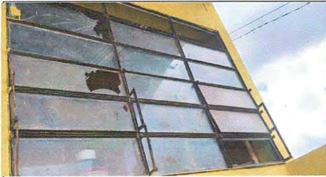
Foto 13: Modulo 1: SUSTITUCIÓN DE VIDRIOS
