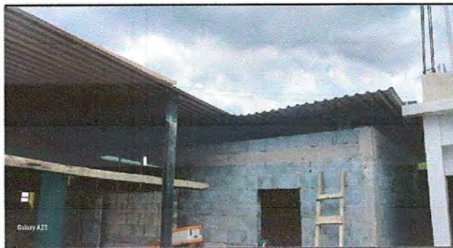
Foto 6: MODULO 1: SUSTITUCIÓN DE LAMINA POR LAMINA TROQUELADA ALUZINC CAL. 26
