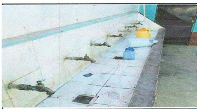
FOTO 12: MODULO 1: SUSTITUCIÓN DE CHORROS
