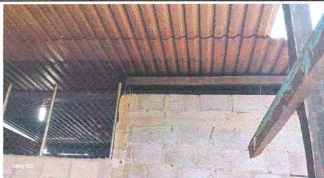
Foto 7: Modulo 1: SUSTITUCIÓN DE ESTRUCTURA PORTANTE DE MADERA POR METAL
