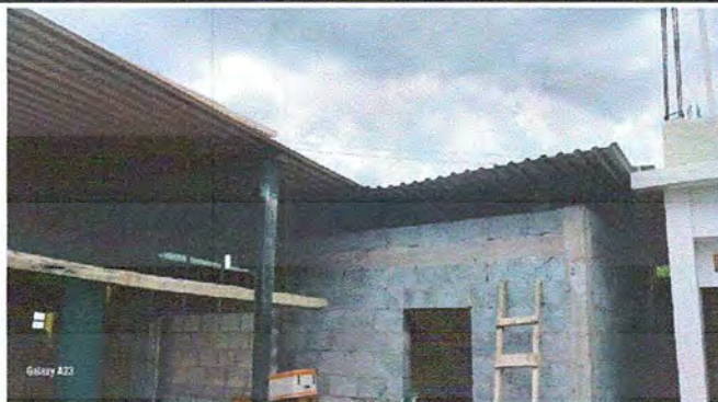
Foto 8: MODULO 1: DESINSTALACIÓN DE LAMINA EXISTENTE
