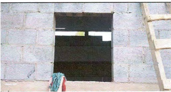
Foto 3: MODULO 1: SUMINISTRO E INSTALACIÓN DE VENTANA DE METAL
