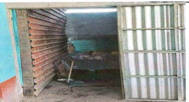
Foto 5: MODULO 1: SUSTITUCIÓN DE PUERTA
