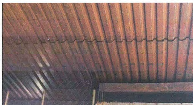
Foto 9: MODULO 1: INSTALACIÓN DE LAMINA TROQUELADA ALUZINC
