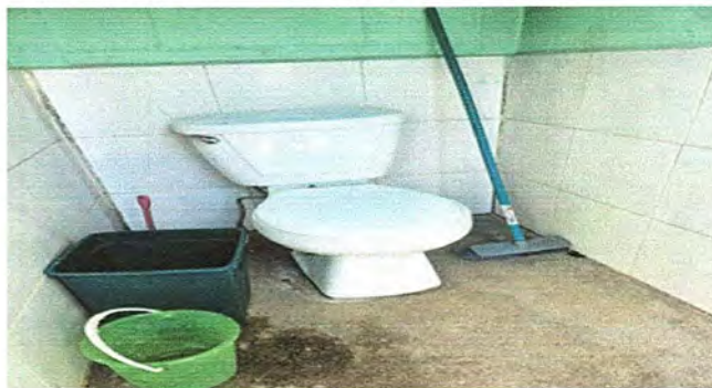
Foto 8: AREADE SANITARIOS: Sustitución de inodoro normal a pequeño.
