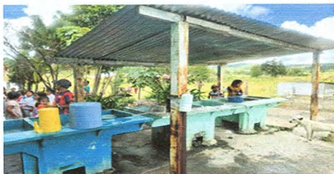
Foto 13: AREA DE PILAS: Sustitución de pila de concreto.
