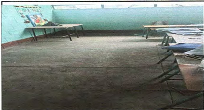
Foto1: MODULO 1: Sustrucción de piso de torta de concreto por piso de granito.
