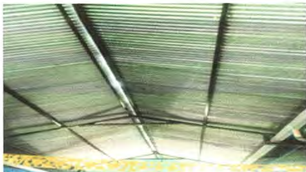
Foto 19: AREA DE PATIO TECHADO: Sustitución de plafoneras instalación de unidades (Incluye interruptor ducto y cable electrico.
