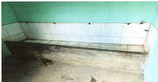
Foto 10: AREA DE SANITARIOS: Sustitución de azulejo en mingitorio
