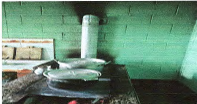
Foto 16: AREA DE COCINA: Reparación de plancha de metal de 3 hornillas.
