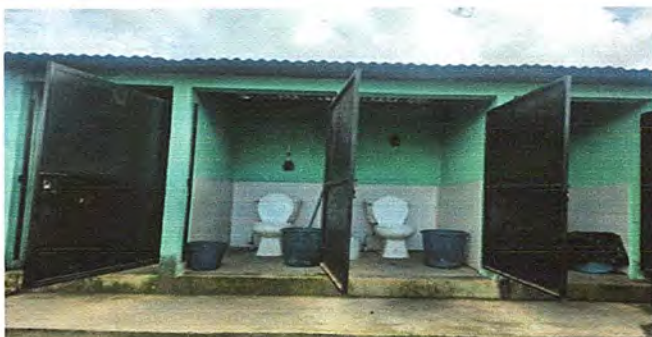
Foto 9 : AREA DE SANITARIOS:Sustitución de piso de torta de concreto por piso antideslizante.
