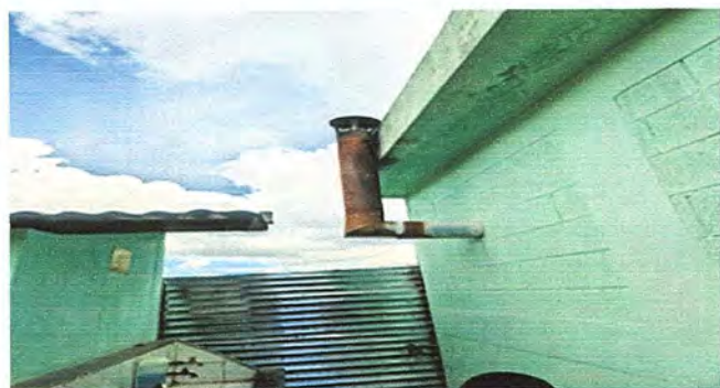
Foto 15: AREA DE COCINA: Sustitución de chimenea de metal.
