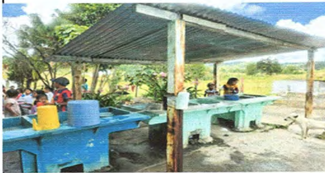
Foto 14: AREA DE PILAS: Mantenimiento a estructura de soporte de metal (columna)
