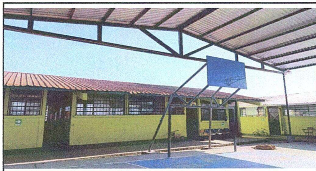
Foto1: Modulo 1: Sustitución de lámina troquelada aluzinc calibre 26, sustitución decapote y sustitución de elementos de fijación.
