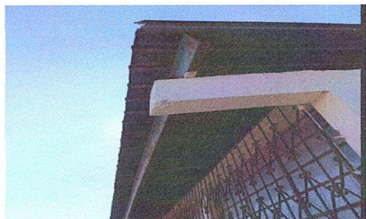
Foto 3: MODULO 1: Sustitución de canal de PVC y sustitución de pescantes.
