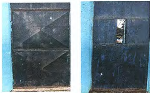
Foto 17: ÁREAS EXTERIORES: Mantenimiento a estructura de puertas
