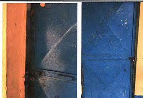
Foto 6: Módulo 2: Mantenimiento a estructura de puerta
