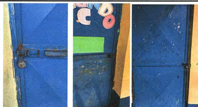
Foto 2 : Módulo 1: Sustitución de chapa
