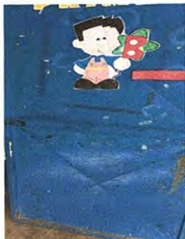
Foto 13: Módulo 5: Mantenimiento a estructura de puerta
