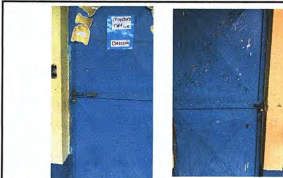
Foto 3: Módulo 1: Mantenimiento a estructura de puerta
