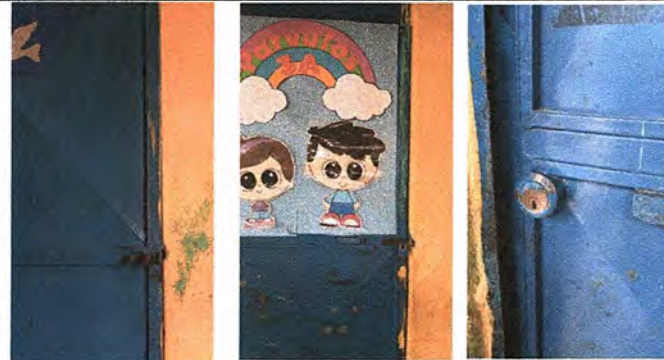
Foto 12: Módulo 3: Sustitución de chapa
