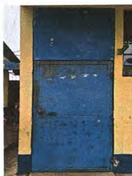
Foto 14: Módulo 6: Mantenimiento a estructura de puerta
