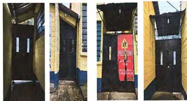
Foto 16: ÁREAS EXTERIORES: Mantenimiento a portones de metal
