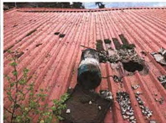
Foto 10: Módulo 3: Sustitución de lámina, por lámina troquelada alizinc calibre 26
