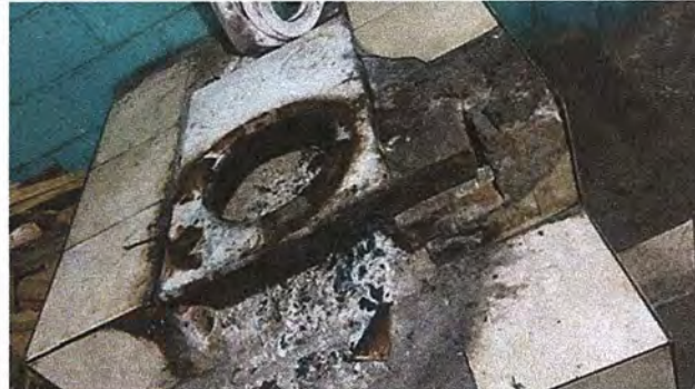
Foto 8: Módulo 3: Sustitución de Estufas rurales completas
