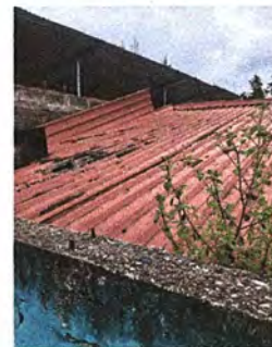
Foto 10: Módulo 3: Sustitución de lámina, por lámina troquelada alizinc calibre 26
