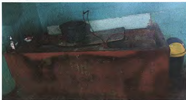
Foto 9: Módulo 3: Sustitución de pila de cemento de 2 lavaderos
