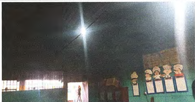
Foto 7: Módulo 3: Reparación del sistema eléctrico
