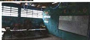
Foto 15: Pintura en muros exteriores e interiores
