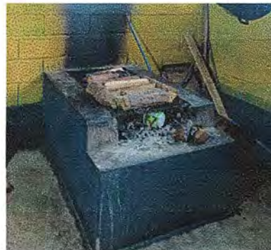
Foto 14: Modulo 2: SUSTITUCIÓN DE ESTUFA RURAL (COMPLETA) INCLUYE CHIMENEA Y PLANCHA HECHA A LA MEDIDA)
