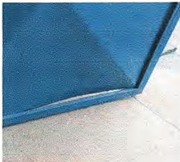
Foto 11: MODULO 2: SUSTITUCIÓN DE PUERTA DE METAL 1.05X2.90m aprox (incluye sobre marco)
