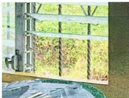
Foto 5: MODULO 1: SUSTITUCIÓN DE VIDRIOS
