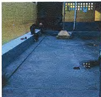
Foto 7: MODULO 1: SUSTITUCIÓN DE LINEA PRINCIPAL DE AGUAS NEGRAS Y REPARACIÓN DE TORTA DE CONCRETO
