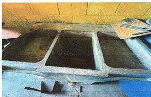
Foto 9: MODULO 1: SUSTITUCIÓN DE PILA DE CONCRETO DE DOS LAVADEROS
