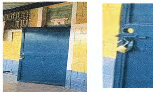
Foto 2: MODULO 1: MANTENIMIENTO DE PUERTA (INCLUYE REAJUSTE DE PUERTA) Y SUSTITUCIÓN DE CHAPA
