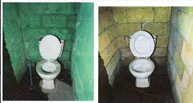
Foto 6: MODULO 1: SUSTITUCIÓN DE INODORO
