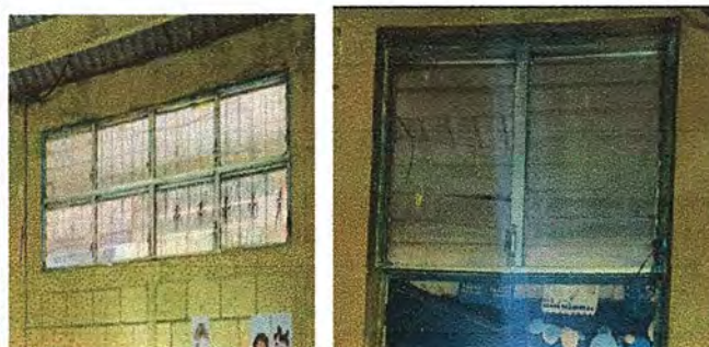
Foto 4: MODULO 1: SUSTITUCIÓN DE VENTANA DE PVC (INCLUYE VENTANA SOBRE PUERTA)
