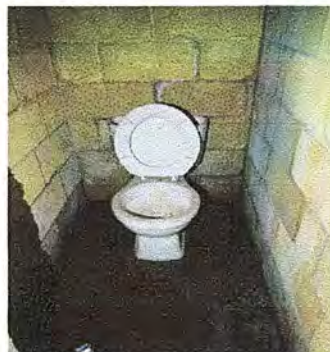
Foto 8: Modulo 1: SUMINISTRO E INSTALACIÓN DE AZULEJO Y SUSTITUCIÓN DE TORTA DE CONCRETO POR PISO CERAMICO ANTIDESLIZANTE
