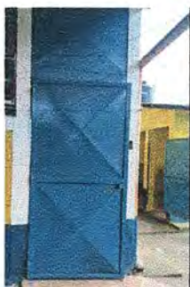
Foto 11: MODULO 2: SUSTITUCIÓN DE PUERTA DE METAL 1.05X2.90m aprox (incluye sobre marco)
