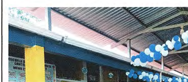
Foto 12: MODULO 2: SUSTITUCIÓN DE CANAL DE PVC Y PESCANTE
