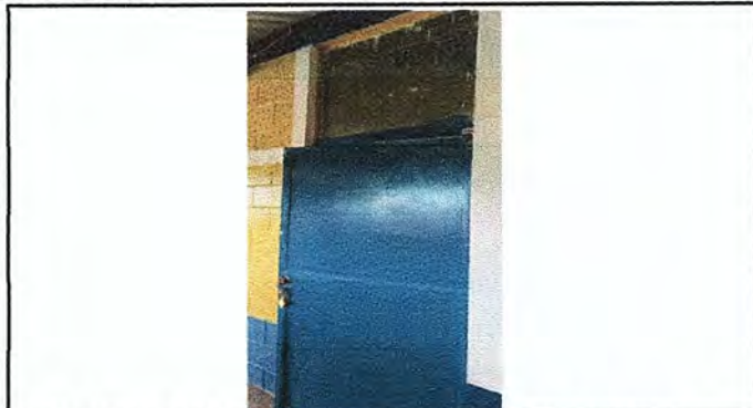
Foto 1: Modulo 1: SUSTITUCIÓN DE PUERTA DE METAL 1.10X2.90m aprox (incluye sobre luz)
