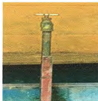
Foto 16: MODULO 3: SUSTITUCIÓN DE LINEA PRICIPAL DE AGUA POTABLE Y SUSTITUCIÓN DE CHORRO
