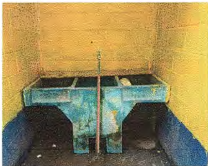
Foto 15: MODULO 3: SUSTITUCIÓN DE PILA DE CONCRETO DE DOS LAVADEROS
