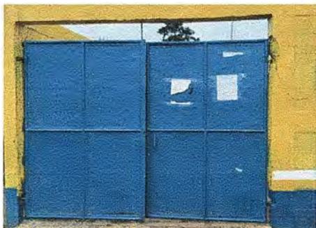
Foto 17: MURO PERIMETRAL: SUSTITUCIÓN DE PORTON 2.70X2.23 m
