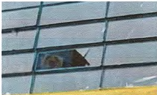
Foto 13: MODULO 2: SUSTITUCIÓN DE VIDRIOS
