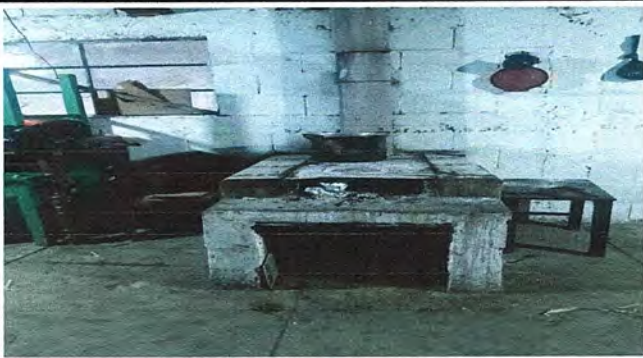
Foto 3: Foto 4: Sustrucción de estufa rural completa incluye chimenea y plancha completa de metal. Sustrucción de piso de torta de concreto. Sustrucción de chimenea de concreto. MÓDULO 1
