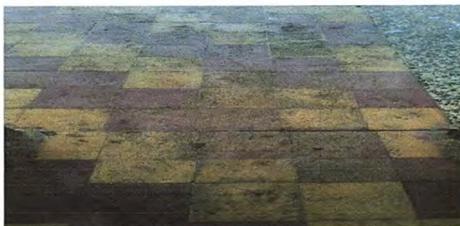
FOTO 9 : Sustrucción de piso por piso granito. MÓDULO 1
