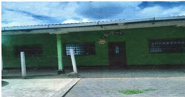
Foto 5: Sustrucción de canal de PVC. MÓDULO 1
