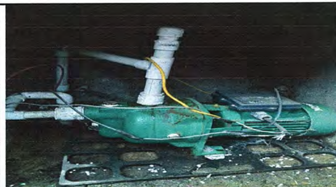
FOTO 10: Sustrucción de bomba de Agua. MÓDULO 1
