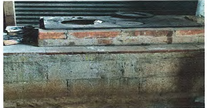
Foto 3: Foto 4: Sustrucción de estufa rural completa incluye chimenea y plancha completa de metal. Sustrucción de piso de torta de concreto. Sustrucción de chimenea de concreto. MÓDULO 1
