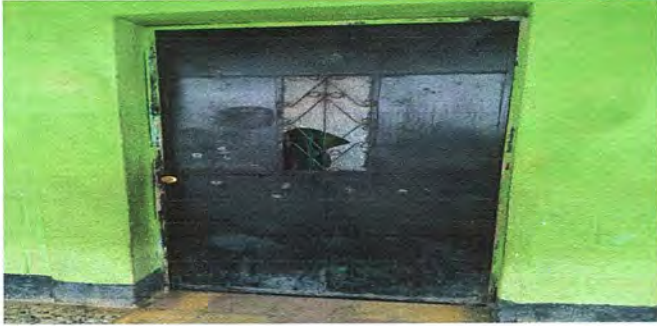
Foto1: Sustrucción de puerta. MÓDULO1
