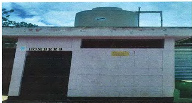
Foto 7: Sustrucción de depósito de agua 1700.Lt. MÓDULO 1
