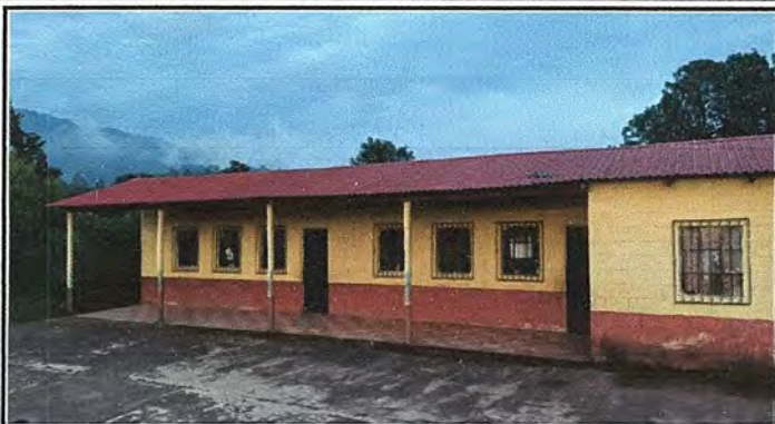
Foto1: Modulo 1: Sustitución de lamina por lamina troquelada, sustitución de capote, sustitución de elementos de fijación.
