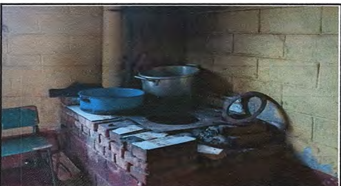
Foto 3: MODULO 1: SUSTITUCIÓN DE ESTUFA RURAL COMPLETA (INCLUYE CHIMENEA Y PLANCHA)
