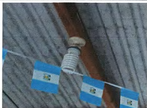
Foto 4: MODULO 1: SUSTITUCIÓN DE FOCO AHORRADOR Y SUSTITUCIÓN DE PLAFONERA.
