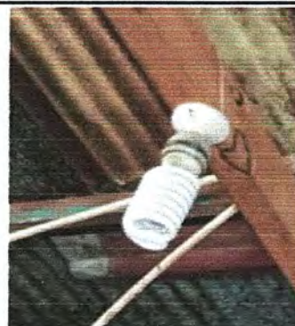
Foto 10: MODULO 2: SUSTITUCIÓN DE FOCO AHORRADOR Y SUSTITUCIÓN DE PLAFONERA.
