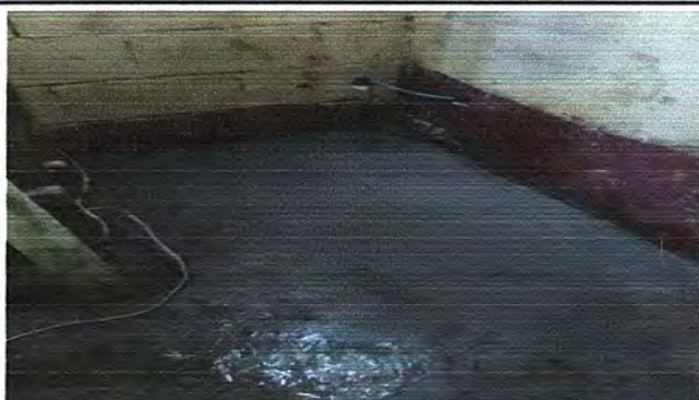
Foto 9: MODULO 2: SUSTITUCIÓN DE PISO DE TORTA DE CONCRETO POR PISO CERAMICO
