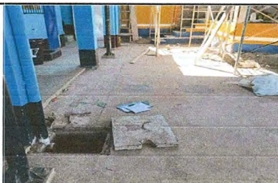
Foto 5: AREAS EXTERIORES: Reparación de torta de concreto en patio y sustrucción de linea principal de agua pluvial.
