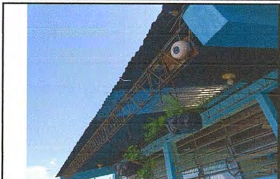
Foto 2: MODULO 1: Mantenimiento de estructura portante de metal, sustrucción de canal de PVC.
