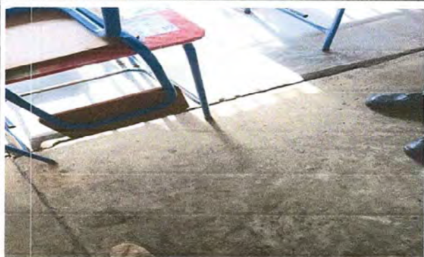
Foto 3: MODULO 1: Reparación de torta de concreto
