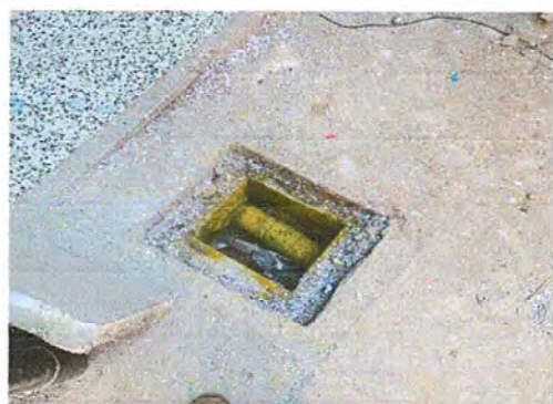
Foto 4: AREAS EXTERIORES: Sustrucción de linea principal de drenaje.
