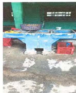
Foto 10: MÓDULO 3 SUSTITUCION DE PILA DE CEMENTO DE DOS LAVADEROS
