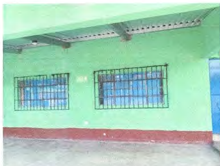
Foto 9: MÓDULO 2 MANTENIMIENTO A BALCONES DE METAL
