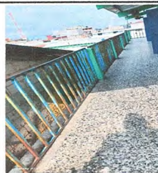
Foto 6: MODULO 2 SUSTITUCION DE BARANDAS DE METAL
