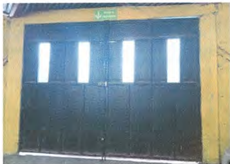
Foto 7: MÓDULO 2 MANTENIMIENTO A PORTÓN DE METAL
