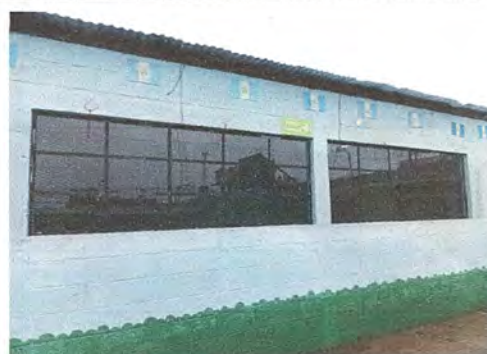
Foto 4: MÓDULO 1 SUSTITUCION DE BALCONES
