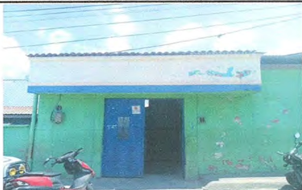
Foto1: MÓDULO 1 MANTENIMIENTO A PORTÓN DE METAL DE ENTRADA PRINCIPAL
