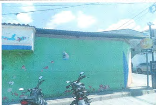
Foto 3: MÓDULO 1 REPELLO EN MURO
