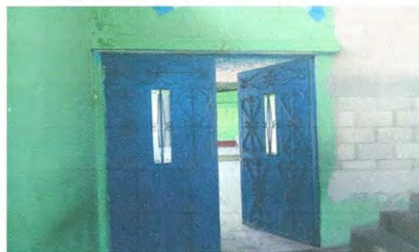
Foto 2: MÓDULO 1 MANTENIMIENTO A PORTÓN DE METAL
