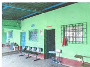
Foto 5: MODULO 1 MANTENIMIENTO A BALCONES DE METAL
