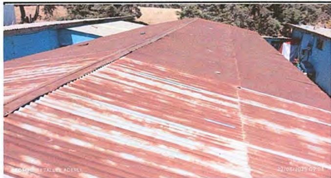
Foto 2: MODULO I. SUSTITUCIÓN DE CAPOTE DE LÁMINA PARA LÁMINA TROQUELADA
