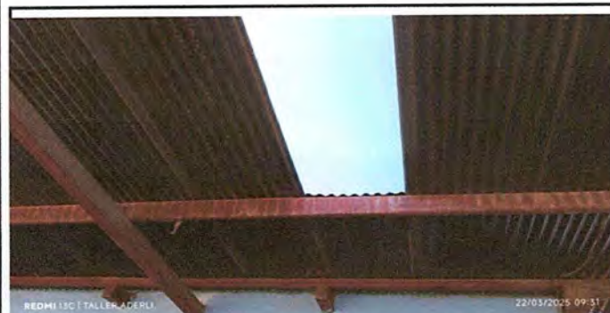
Foto5: MODULO III. SUSTITUCIÓN DE LAMINA, POR LAMINA TROQUELADA ALUZINC CALIBRE 26
