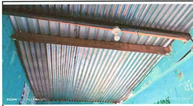
Foto 4: MODULO II. DESINSTALACIÓN E INSTALACIÓN DE LÁMINA EXISTENTE
