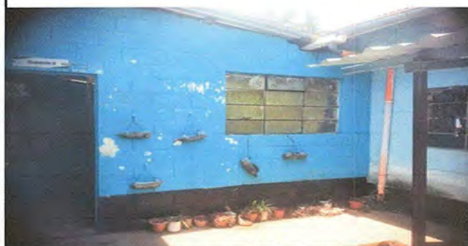
Foto 8: PINTURA DE MUROS EXTERIORES
