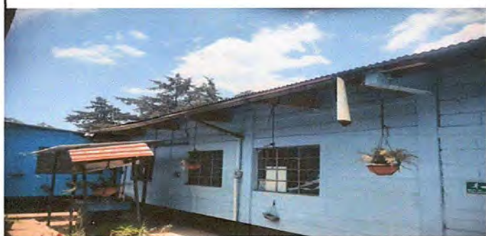
Foto7: PINTURA DE MUROS EXTERIORES
