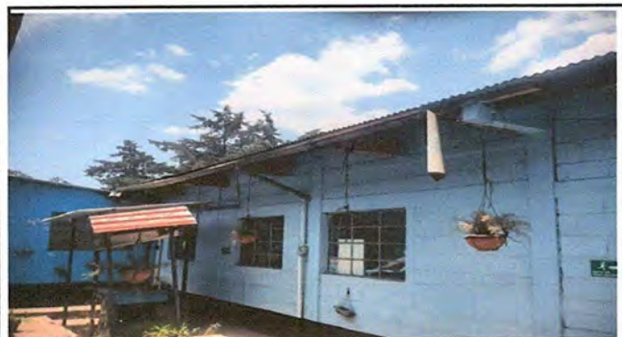
Foto 3: MODULO I. SUSTITUCIÓN DE CANALES DE METAL
