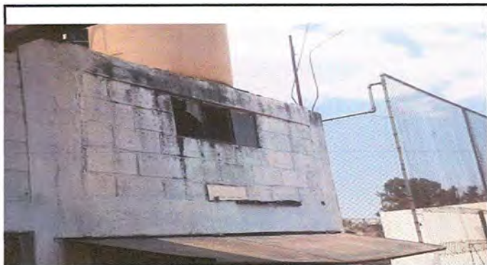
Foto 9: PINTURA DE MUROS EXTERIORES
