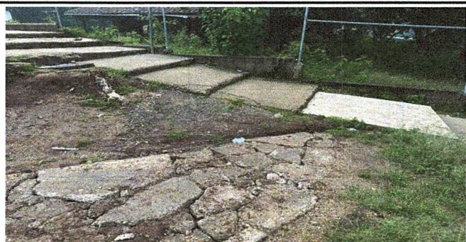
Foto 3: PATIO: Reparación planchas de concreto de patio
