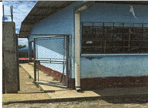
Foto 4: MURO PERIMETRAL: sustitución de puerta
