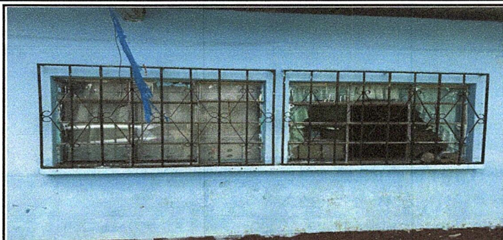
Foto 1: MÓDULO 1: sustitución de estructura de metal de ventana por PVC
