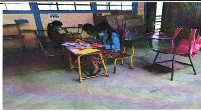
FOTO 8: MODULO 2: SUSTITUCION DE PISO DE TORTA DE CEMENTO POR PISO CERAMICO
