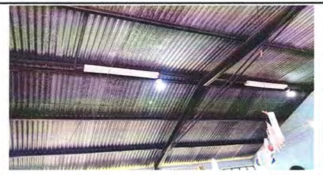
FOTO 10: MODULO 3: SUSTITUCION DE BOMBILLAS POR LAMPARAS DE LUZ LED.
