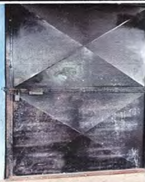
FOTO 3: MODULO 2: MANTENIMIENTO A ESTRUCTURAS (LIJADO, CAMBIO DE TUBO, CEPILLADO, SUSTITUCION Y APLICACIÓN DE PINTURA) A PUERTAS SERVICIOS SANITARIOS.
