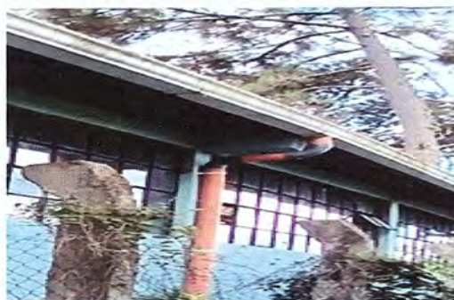
FOTO 5: MODULO 2: SUSTITUCION DE SOPORTE O PESCANTE PARA CANAL
