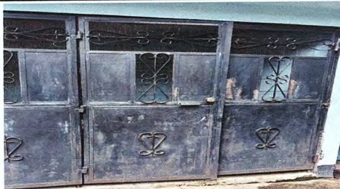
FOTO 14: AREA DE BAÑOS : MANTENIMIENTO A ESTRUCTURAS (LIJADO, CAMBIO DE TUBO, CEPILLADO, SUSTITUCION Y APLICACIÓN DE PINTURA) A PUERTAS SERVICIOS SANITARIOS.
