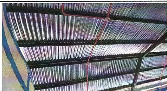
FOTO 7: MODULO 2: SUSTITUCION DE BOMBILLAS POR LAMPARAS DE LUZ LED
