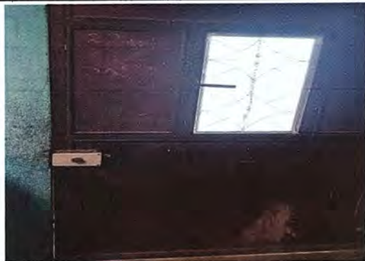
FOTO 1: MODULO 1: SUSTITUCION DE CHAPAS
