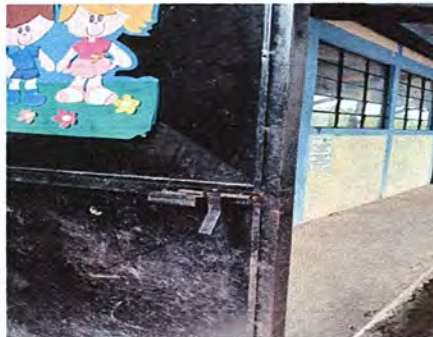
FOTO 6: MODULO 2: SUSTITUCION DE CHAPAS
