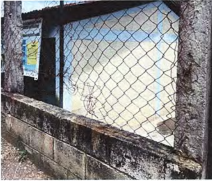
FOTO 19: REPARACION DE TUBO HG Y MALLA GALVANIZADA
