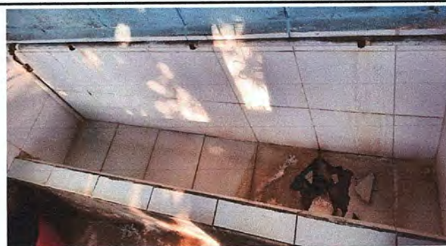
FOT 16: AREA DE BAÑOS SUSTITUCION DE AZULEJOS DE MINGINTORIO
