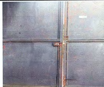
FOTO 18: MURO PERIMETRAL: SUSTITUCION DE CHAPA
