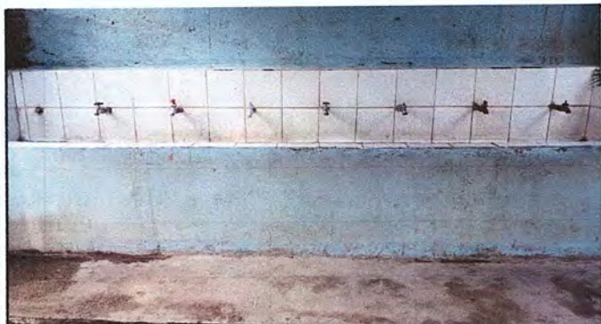
FOTO 15: AREA DE BAÑOS: SUSTITUCION DE AZULEJOS DE LAVA MANOS
