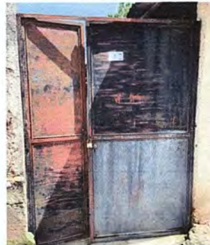
FOTO 2: MODULO1: MANTENIMIENTO A ESTRUCTURAS (LIJADO, CAMBIO DE TUBO, CEPILLADO, SUSTITUCION Y APLICACIÓN DE PINTURA) A PUERTAS SERVICIOS SANITARIOS.
