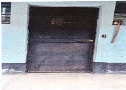
FOTO 13: MODULO 3: SUSTITUCION DE CHAPA
