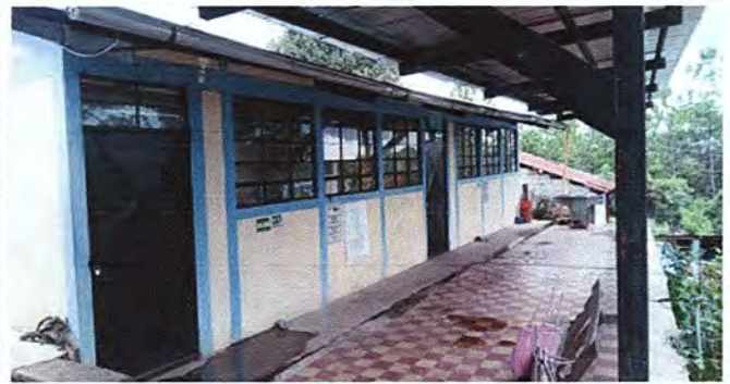
FOTO 20: MANTENIMIENTO, PINTURA GENERAL: PINTURA DE MUROS EXTERIORES E INTERIORES
