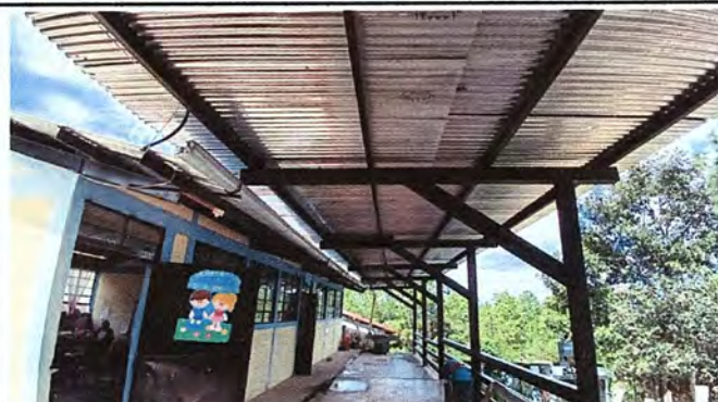
FOTO 4: MODULO 2: SUSTITUCION DE CANALES DE LAMINA POR CANALES AMERICANOS.
