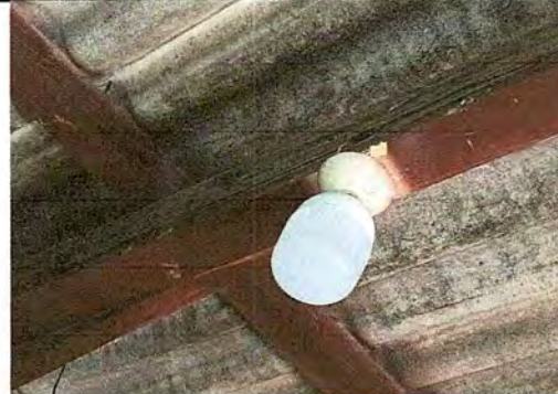
Módulo 1. Foto 6: Sustitución de focos.
