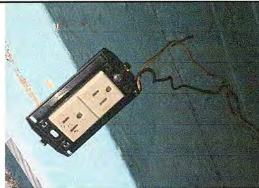
Módulo 1. Foto 4: Sustitución de tomacorrientes.
