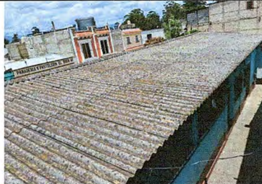
Módulo 1. Foto 2: Sustitución de lámina de duralita por lámina troquelada.
