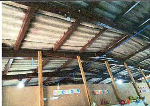
Módulo 1. Foto1: Sustitución de madera de soporte por metal.
