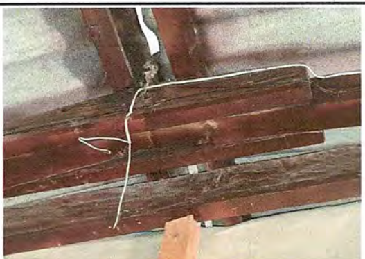
Módulo 1. Foto 3: Sustitución de cableado eléctrico.
