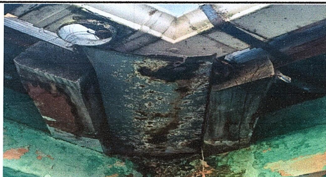
Foto 3: MODULO 1: Sustitución de canal de metal.
