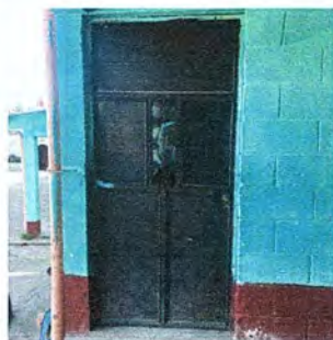
Foto 5. Modulo 3: Sustitucion de chapas
