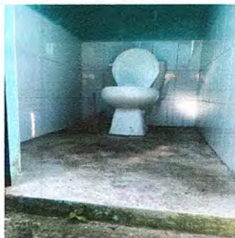
Foto 1. Modulo 1: Sustitucion de Inodoros
