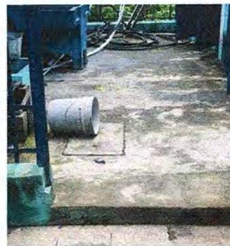
Foto 10. LOSA DE PATIO. sustitucion de planchas de concreto de patio
