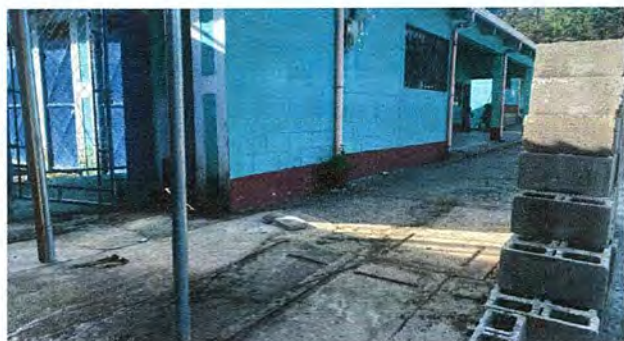
Foto 9. REPARACION DE RED DE DRENAJE. Sustitucion de Tuberia PVC lineal principal de Aguas negras
