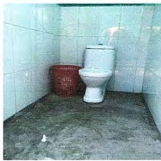
Foto 3. Modulo 1: sustitucion de piso de torta de concreto por piso Ceramico
