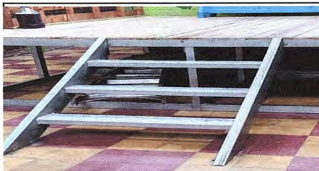
Foto 15: SALÓN Sustitución de gradas de metal por gradas de madera.
