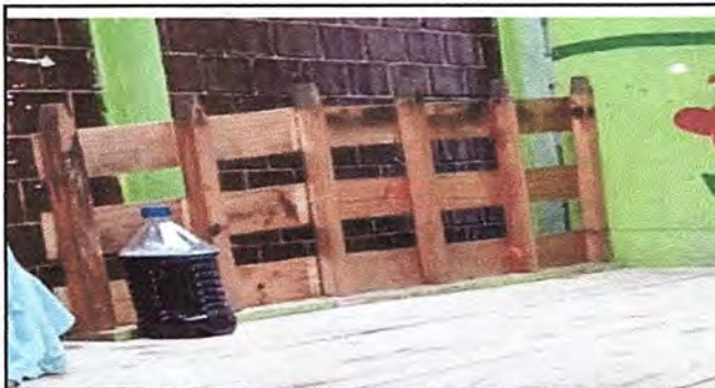
Foto 16: SALÓN Sustitución de baranda de madera por madera.
