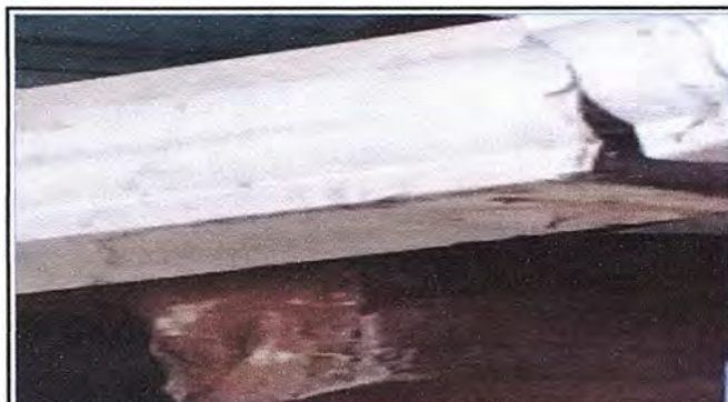
Foto 9: MODULO 2 Sustitución de soporte o pescante de metal para el canal.
