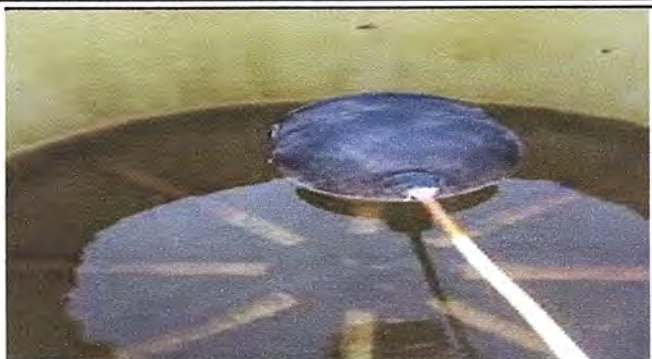
Foto 13: PATIO Sustitución de accesorios deposito de agua.
