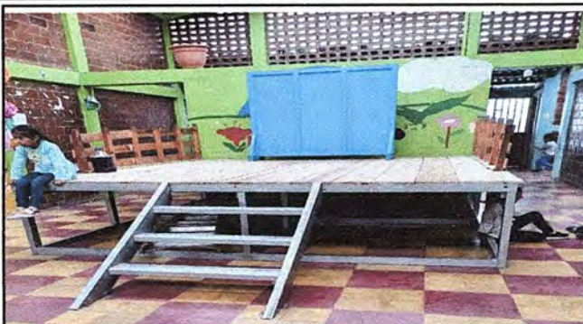
Foto 14: SALÓN Reparación de escenario.
