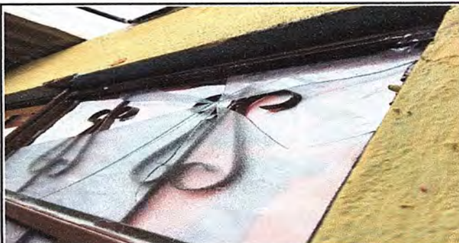
Foto 6: MODULO 1 Sustitución de vidrio.
