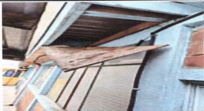
Foto1: MODULO 1 Sustitución de machimbre.
