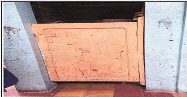
Foto 12: MODULO 2 Sustitución de puerta.
