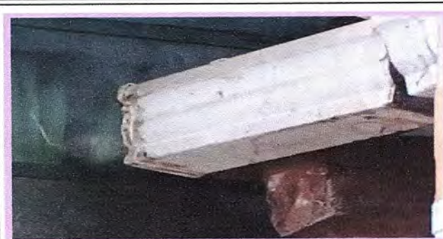
Foto 2: MODULO 1 Sustitución de canal de PVC.
