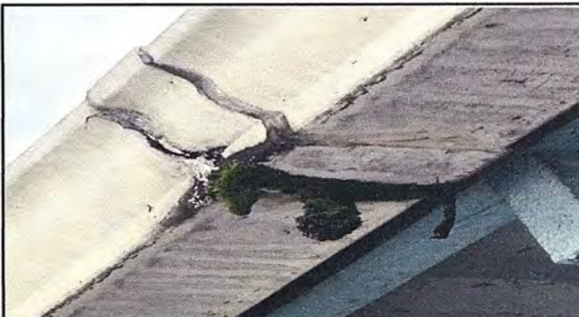
Foto 8: MODULO 2 Sustitución de canal de PVC.
