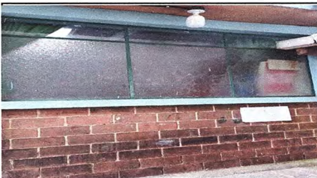
Foto 10: MODULO 2 Sustitución de estructura de metal de ventana por PVC.
