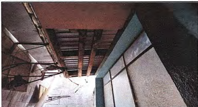
Foto 7: MODULO 2 Sustitución de machimbre.
