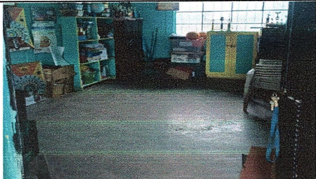
Foto 13: MODULO 2: SUSTITUCIÓN DE TORTA DE CONCRETO POR PISO CERAMICO.
