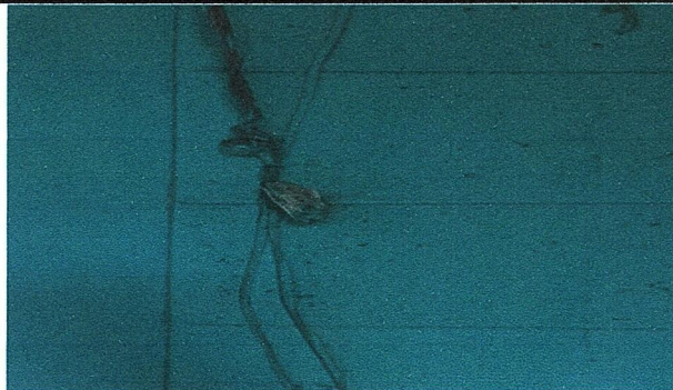
Foto 11: MODULO 2: REPARACIÓN DE CABLEADO ELECTRICO Y SUSTITUCIÓN DE DUCTO ELECTRICO + ACCESORIOS
