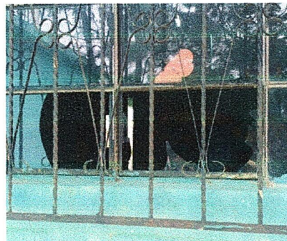
Foto 14: MODULO 2: SUSTITUCIÓN DE VIDRIOS
