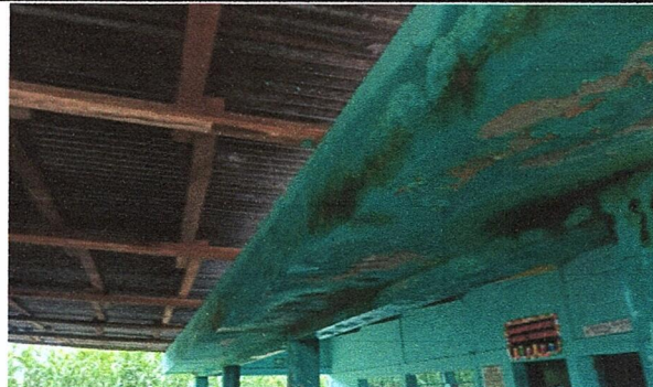
Foto 6: MODULO 1: REPARACIÓN DE CANAL DE CONCRETO.
