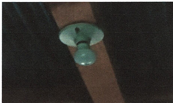
Foto 9: MODULO 2: SUSTITUCIÓN DE FOCOS LED Y SUSTITUCIÓN DE PLAFONERAS
