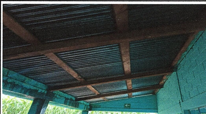
Foto 2: MODULO 1: Sustitución de estructura de madera por metal.
