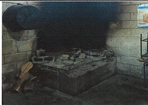
Foto 12: MODULO 2: SUSTITUCIÓN DE ESTUFA RURAL COMPLETA
