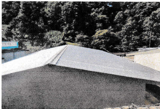
Foto1: Sustitución de lámina troquelada calibre 26 para 2 aulas
