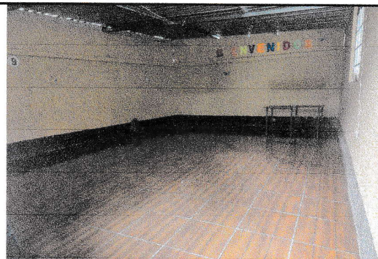
Foto 4: sustitucion de piso en aula
