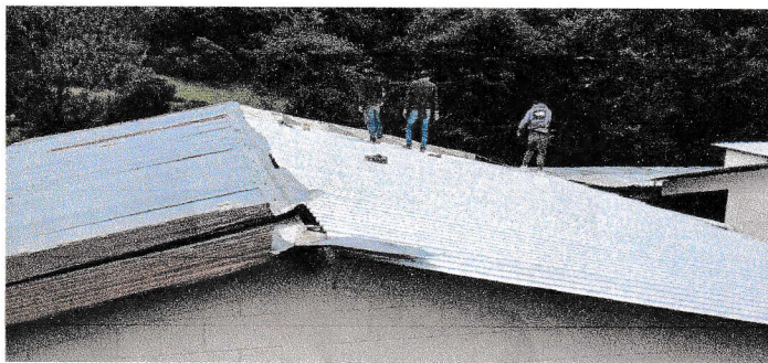
Foto 1: Sustitución de lámina troquelada calibre 26 para 2 aulas
