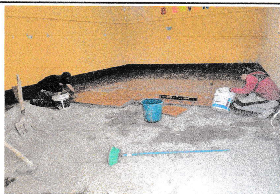
Foto 4: sustitucion de piso en aula
