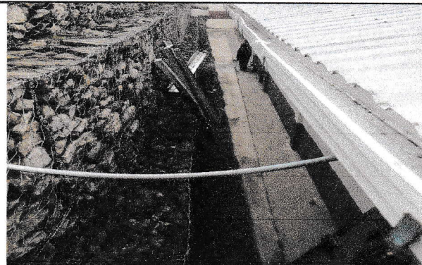
Foto 2: sustitucion de canales en aulas y patios
