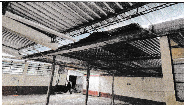
No.3 Sustitucion de lámina y estructura de patio + ventana de iluminación
