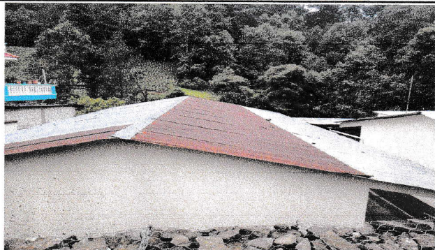
No.1 Sustitucion de lámina troquelada cal. 26 para 2 aulas
