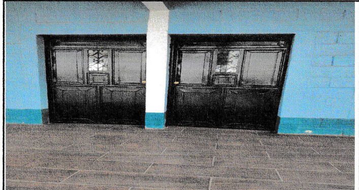
Foto 2: Mantenimiento correctivo de disminución de puertas
