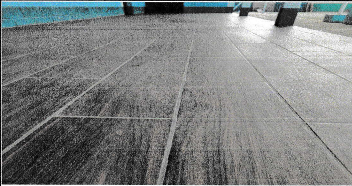
Foto 1: Sustrucción de piso a piso cerámico
