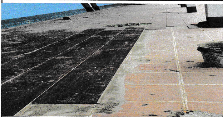
Foto1:Sustitución de piso a piso Cerámico
