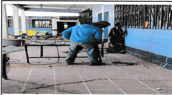
Foto 2: Mantenimiento Correctivo de Disminución de Puertas
