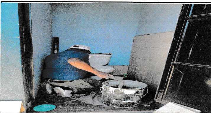
Foto 3: Sustitución de piso a piso cerámico y reparación de paredes con azulejo de baños
