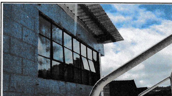
Foto 4: Sustitución de balcón
