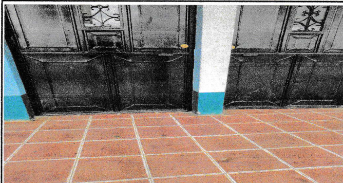
No.2 Mantenimiento correctivo de disminución de puertas
