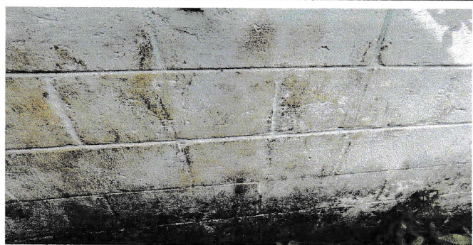
No5 Mantenimiento preventivo de pintura en muros
