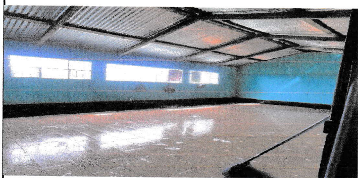
Foto1: Sustitución de piso cerámico en aulas y cocina
