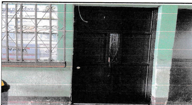
Foto 4: Sustitución de puerta metálica
