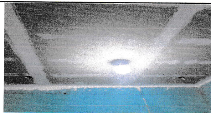
Foto 6: Sustitución de cielo falso de tablayeso
