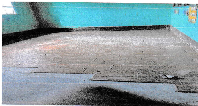
Foto1: Sustitución de piso en aulas y cocina
