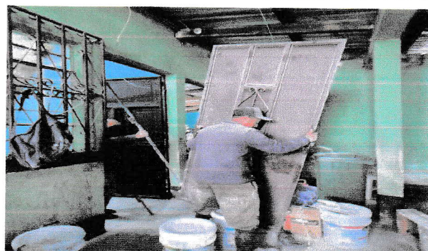
Foto 4: Sustitución de puerta metálica
