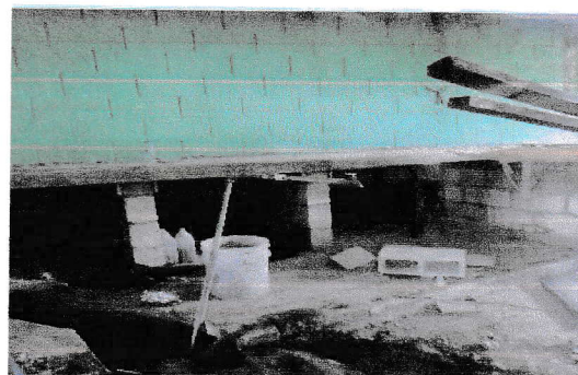
Foto 2: Sustitución de mesas de trabajo de concreto en cocina
