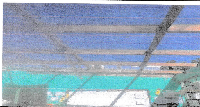
Foto 3: Sustitución de lámina troquelada cal. 26 en aulas y cocina
