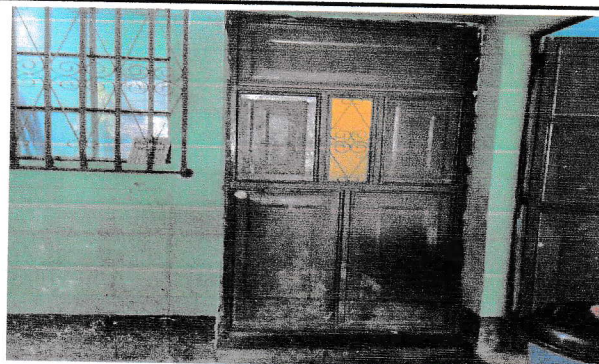
No.4 Sustitución de puerta metálica
