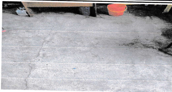
No.1 Sustitución de piso cerámico en aulas y cocina
