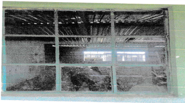
No.5 Sustitución de balcón metálico
