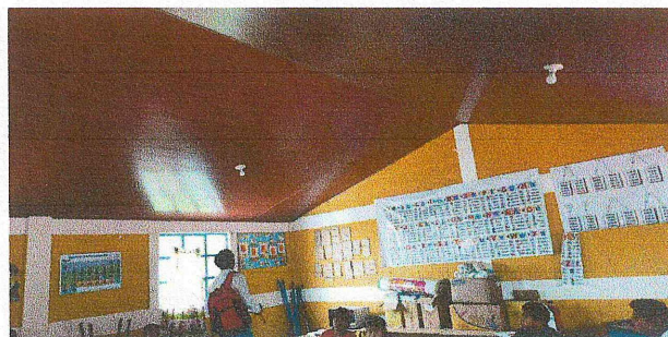
Sustitución de cielo falso de pvc
