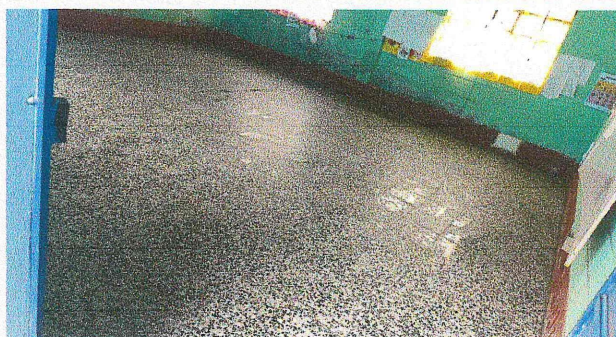
Sustitución de piso granito en 1 aula
