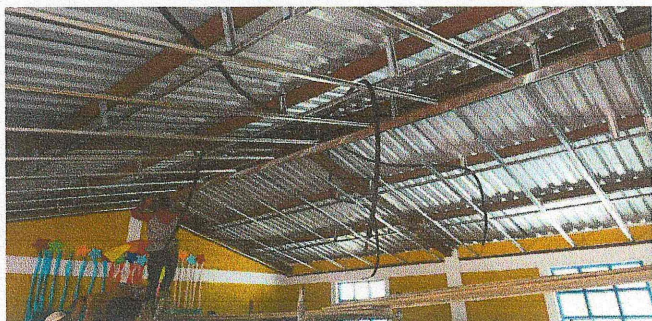
sustitución de cableado electrico en 6 aulas
