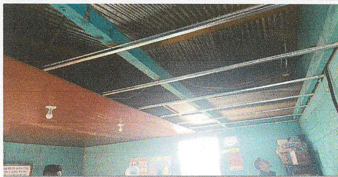
Sustitución de cielo falso de pvc
