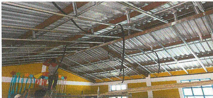
sustitución de cableado electrico en 6 aulas
