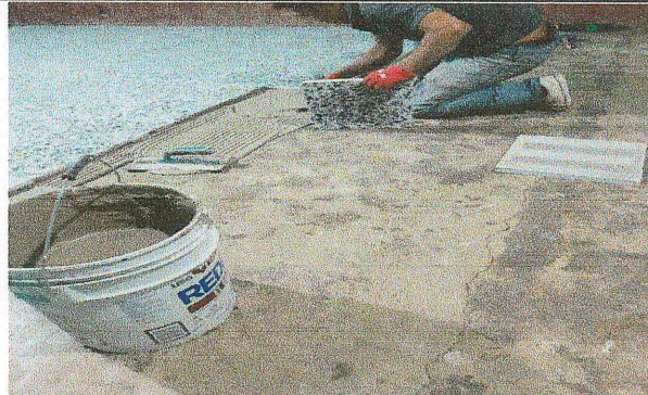
Sustitución de piso granito en 1 aula
