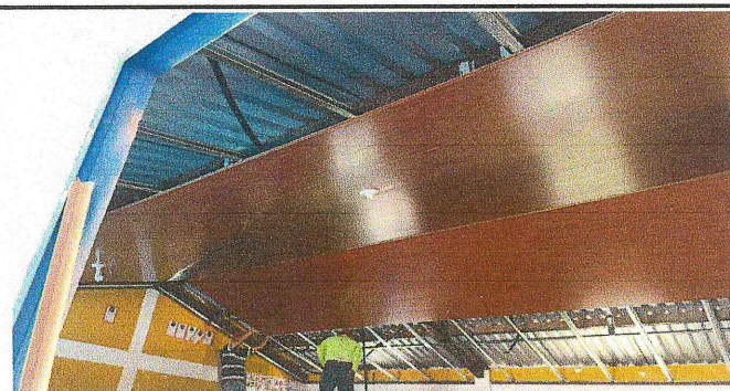
Sustitución de cielo falso de pvc
