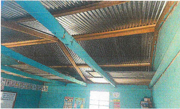
Sustitución de cielo falso de pvc
