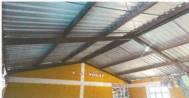
Sustitución de cielo falso de pvc
