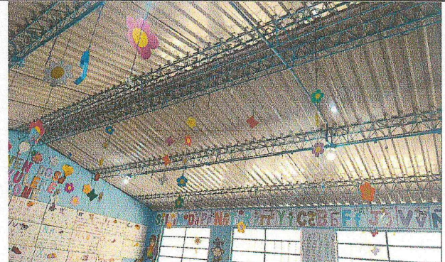
Sustitución de cielo falso de pvc
