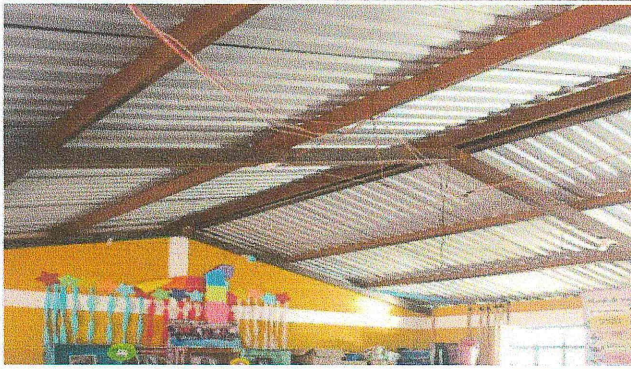
sustitución de cableado electrico en 6 aulas
