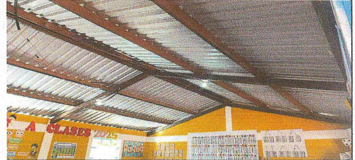
Sustitución de cielo falso de pvc
