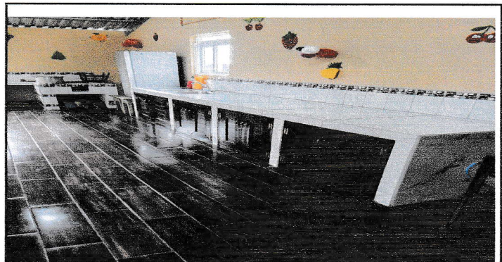
Foto 3: Sustrucción de gabinetes hechos de madera y mejoramiento de puertas de gabinetes pvc (incluye la instalación de lavatrastos)
