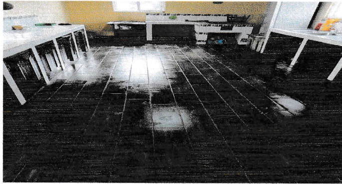
Foto 1: Sustrucción de piso de concreto a piso cerámico en cocina
