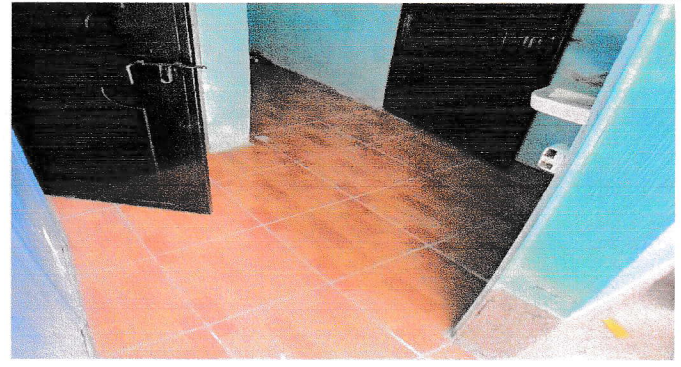
Foto 1: Sustrucción de piso de concreto a piso cerámico en servicios sanitarios
