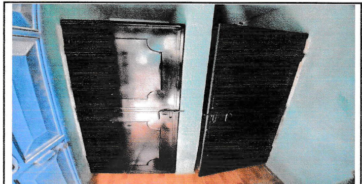
Foto 5: Sustrucción de puertas de madera a puertas de metal en servicios sanitarios
