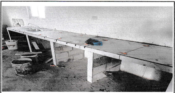
Foto 3: Sustrucción de gabinetes hechos y mejoramiento de puertas de gabinetes pvc (incluye la instalación de lavatrastos).
