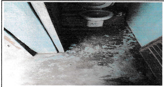
No. 1 Sustitución de piso de concreto a piso cerámico en servicios sanitarios
