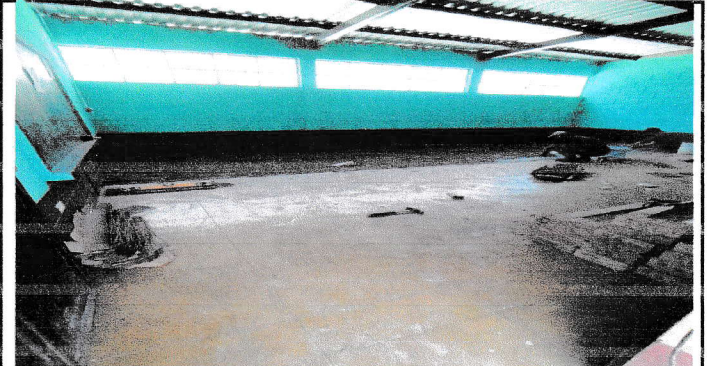
No. 2: SUSTITUCION DE PISO PORCELANATO DEL MODULO 1.
