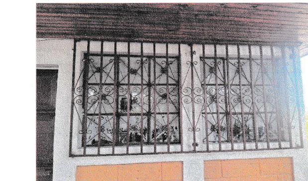
Sustitución de blaques metálicos a balcones metálicos de comedor escolar
