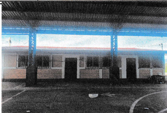
Sustitución de lámina a lámina troquelada color rojo calibre 26
