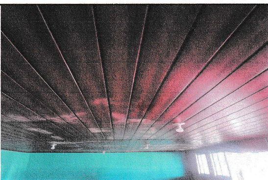
Sustitución de cielo falso de machimbre a cielo falso PVC en comedor escolar
