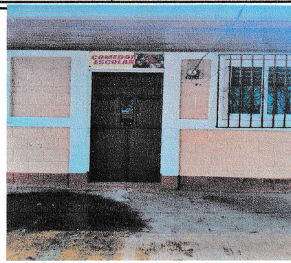
Mantenimiento de puerta metálica en comedor escolar
