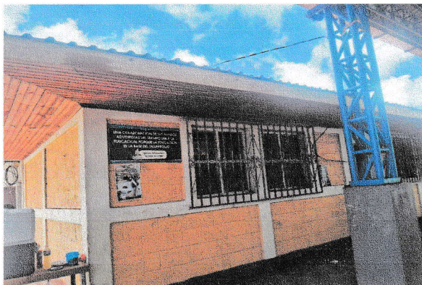
Mantenimiento de pintura de balcones metálicos de comedor escolar
