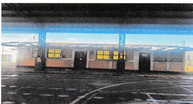
Foto1: Sustitución de lámina a lámina troquelada color rojo calibre 26
