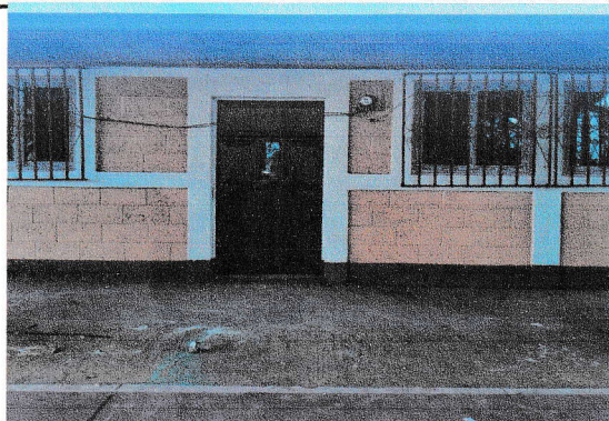
Foto 2: Mantenimiento de puertas metálicas en comedor
