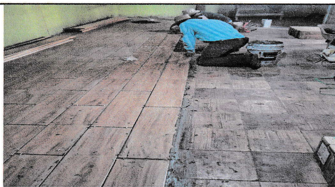
Foto 3: Sustitución de piso de concreto a piso cerámico
